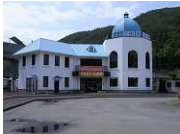
Fig. 11 Shimanokoshi Sta. (before)
