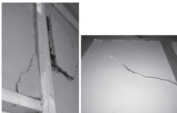
a) 内壁のひび割れ      b) 外壁のひび割れ
