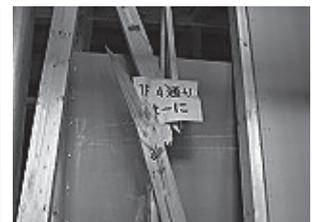
写真6 筋かいの座屈破壊
