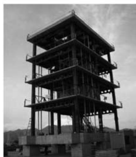
(c) 床スラブ打設後の骨組
