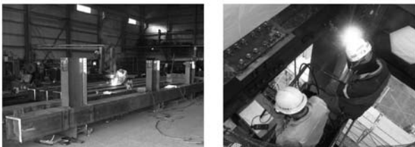
(a) 工場溶接
