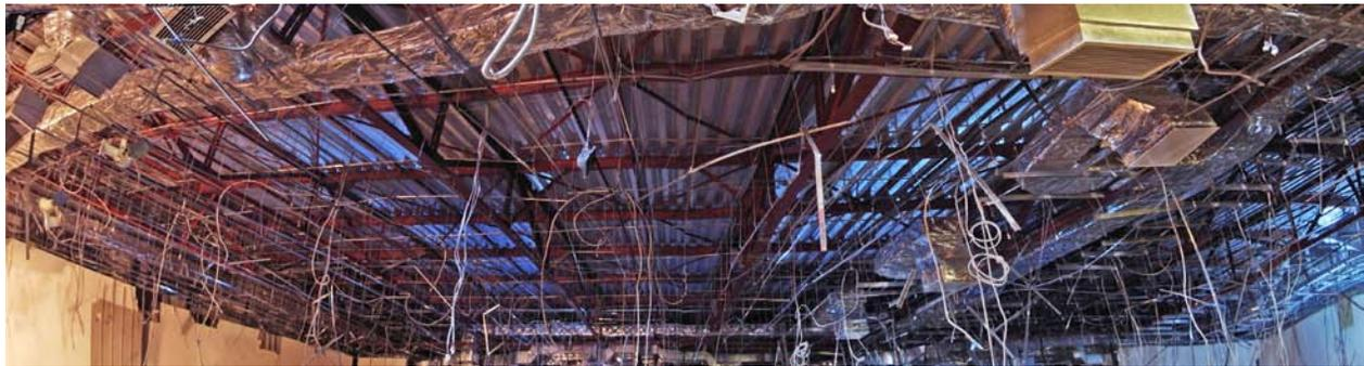
写真2 東北地方北太平洋沖地震による天井落下被害例
