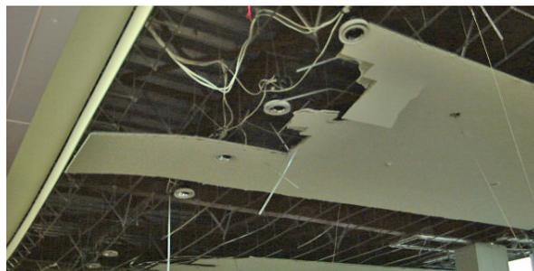
写真3 天井落下被害例 (2003年) 写真提供：東急建設中本康氏
