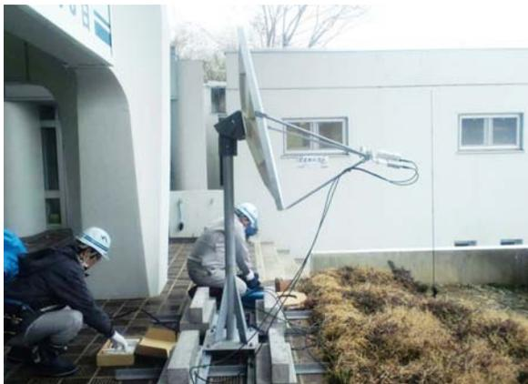
図2 衛星回線を使った通信復旧作業
