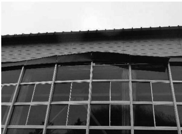
写真7 剥落しかかっている窓サッシ(外観)
