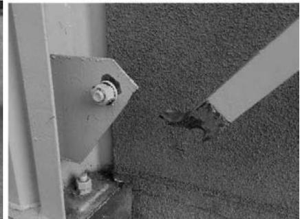
写真3 ブレース端接合部での破断
