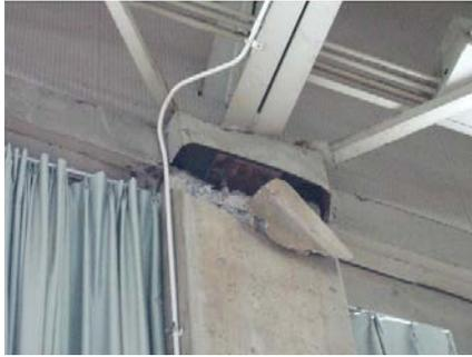
写真4 鉄骨屋根定着部の被害
