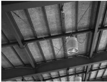
写真5 大きく伸ばされた水平ブレース
