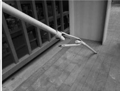
写真2 ターンバックルブレースの破断
