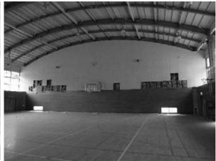
写真6 変形に追従できず剥離した内装
