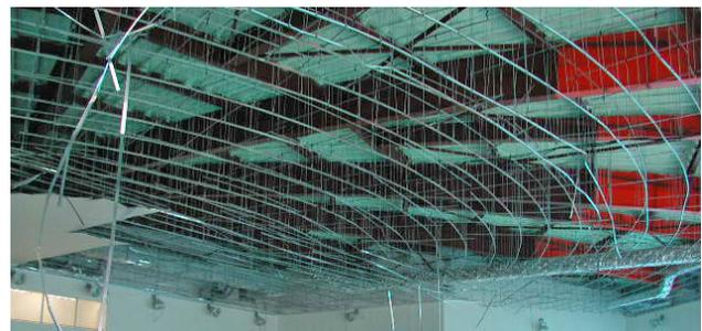
写真4 天井落下被害例 (2005年)
