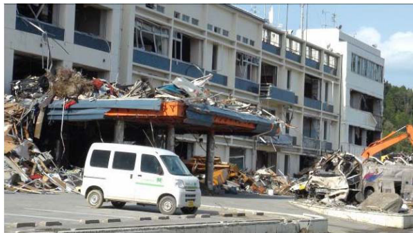
写真1 津波の直撃を受けた陸前高田市役所
