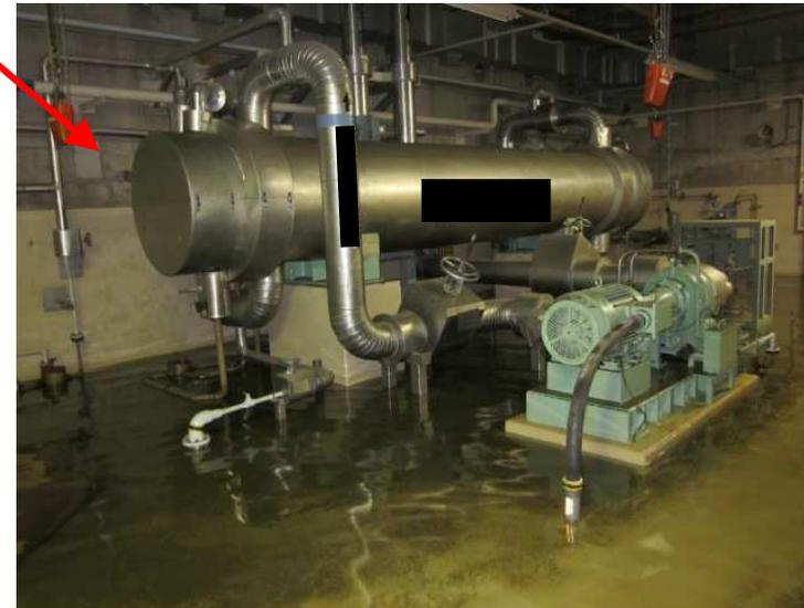
◇上記冷却系統の機能喪失により、非常用ディーゼル発電機(B)，(H)が自動停止したが、以下のとおり、原子炉冷却機能は確保されていた。
