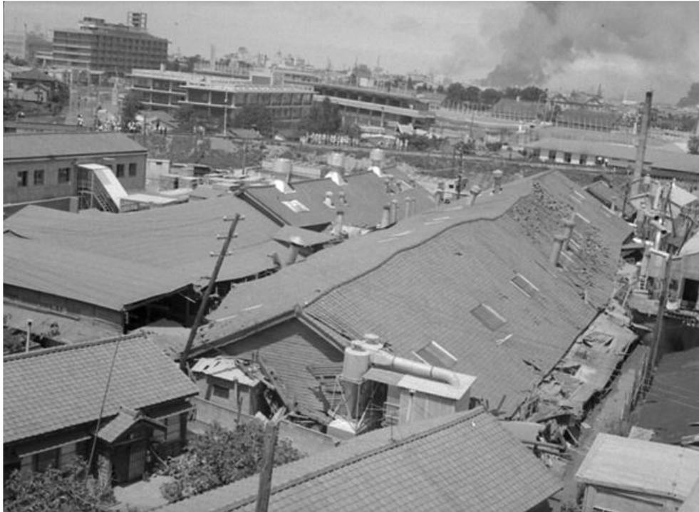
No.27の写真の中央の建物をクローズアップ。建物は沈下しただけでなく軒先が右の方に引っ張られるようにせり出しており、右方向(川の方)に地盤が動いたために変形したことがわかる。写真右手の地面も噴砂で覆われている。
