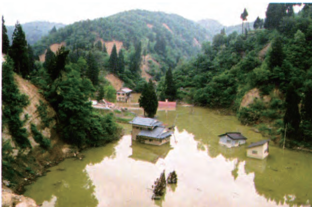
写真1 天然ダム上流湛水状況 (2004)
