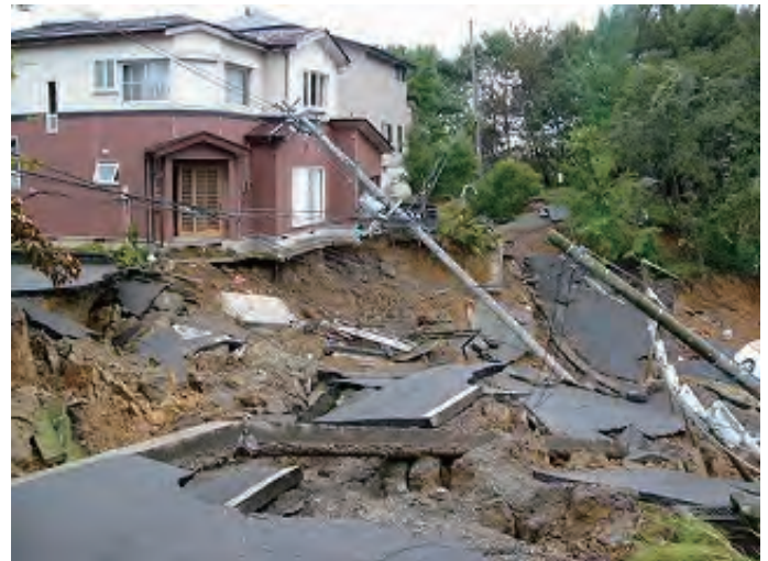
写真1 谷埋め盛土の崩壊
