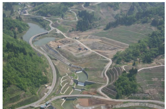
写真2 東竹沢地区対策工事完成状況
