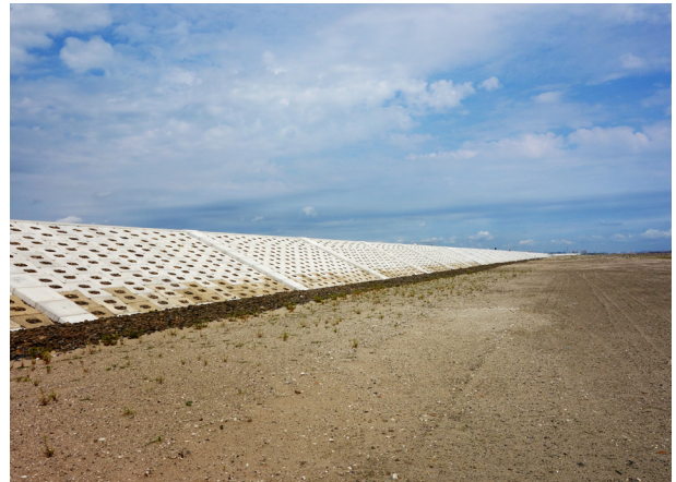
写真1 完成した防潮堤(仙台空港付近)
