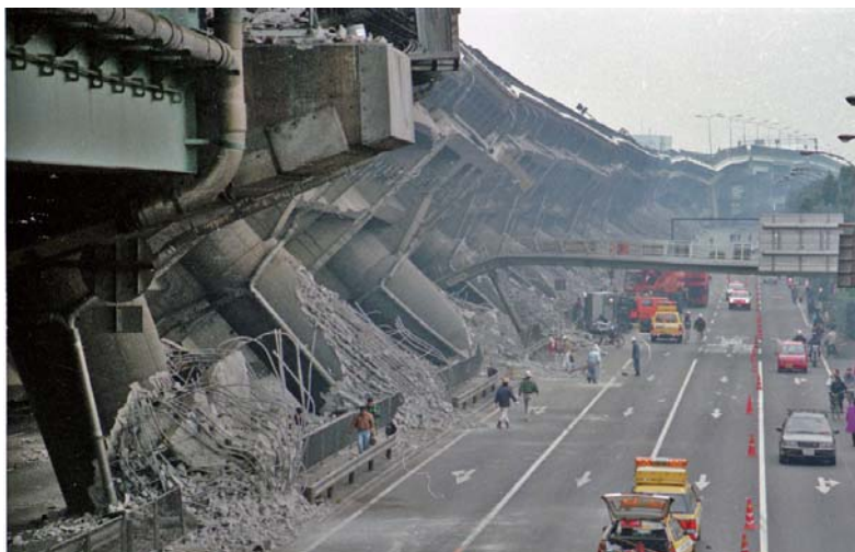
阪神高速道路神戸線の倒壊
