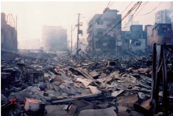
多くの木造住宅の倒壊・焼失
