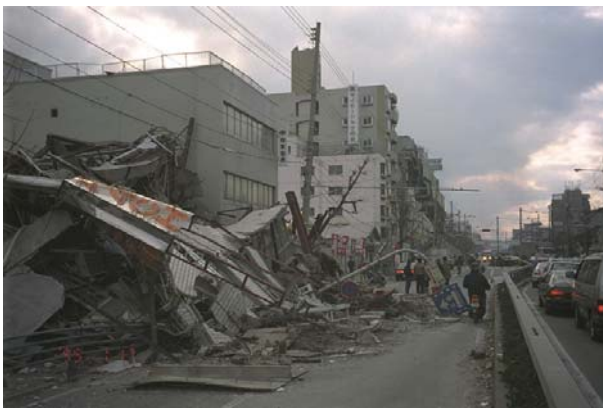
建物の幹線道路側への倒壊
