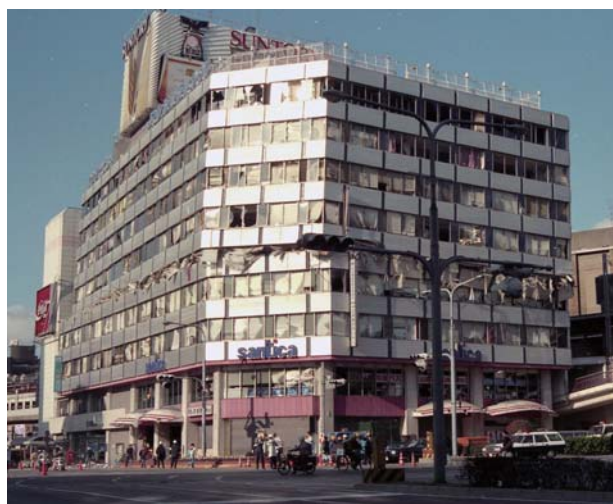
被災したビル
