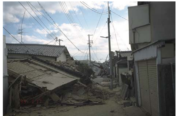
木造住宅の倒壊による道路閉塞
