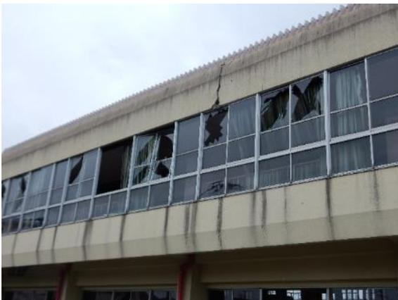
2階張り出し部に立つサッシのガラスの破損
