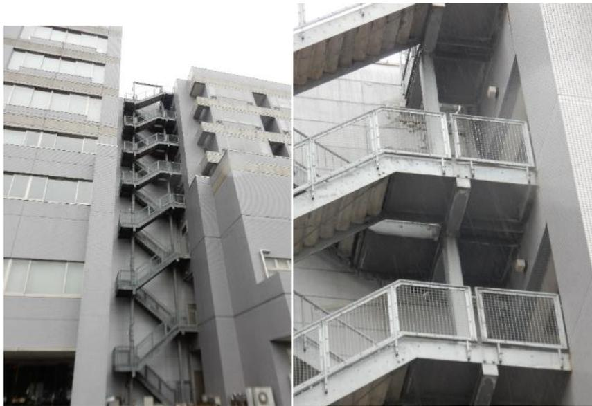
外付け階段取り付け部の被害
