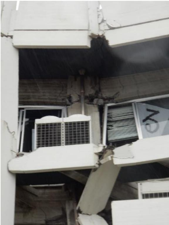
柱は壁柱か？奥行きが薄く見える
