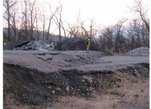
写真2 南側の砂利集積場にも地表地震断層が連続し、東側上がり約80～85cmの変位が認められた。地表地震断層は幅1～2m程度の撓曲を伴い、隆起側には開口割れ目も多数発達している(地点①)
