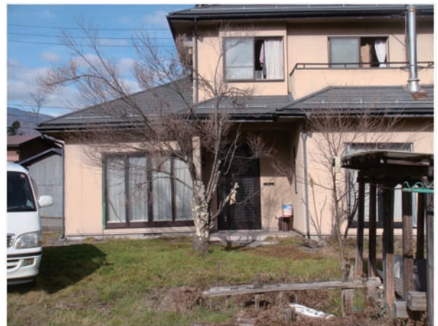
写真5 家屋と車の間に地表地震断層が出現した。撓曲変形に伴って家屋左手(西側)の一階建て部分が西へ撓む様子がわかる(地点④)
