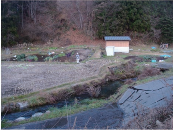
写真1 塩島地区 手前から道路、水田、畑が変位を受けており、水田の変位から今回の地震のみによる変位であることが明らかである。変位量は道路で約90cm、水田で約85cm、畑の畔で約80cm。畑の畔では東側の地盤が西側に衝上する様子をはっきり確認できる(地点①)
