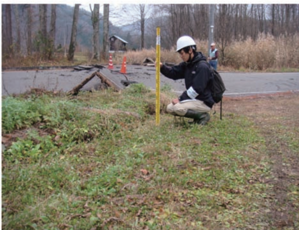
写真3 松川右岸の道路 道路脇に明瞭な変位が認められた。後方は東側が隆起しつつ座屈変形した路面。地表地震断層のみかけの走向はN30° E、変位量は約27cm(地点②)
