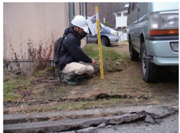
写真6 家をかすめた地表地震断層。崖の比高は約30cmだが、変位は緩やかな撓曲変形を伴っており、写真5に見られるように家屋の基礎自体も撓んでいる。地表地震断層は手前側に連続し道路にも変形を与えている。写真5の家屋を反対側(北側)から撮影(地点④)
