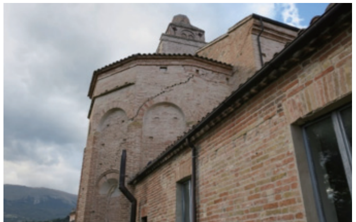
Damage of Chiesa di San Francesco (Amandola)
