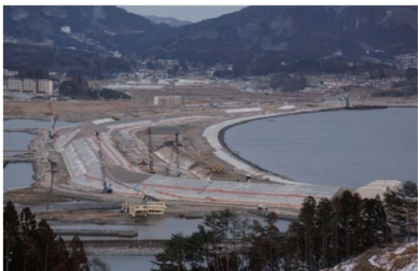
写真1 高田地区に建設中の緩傾斜式防潮堤 (陸前高田市提供)
