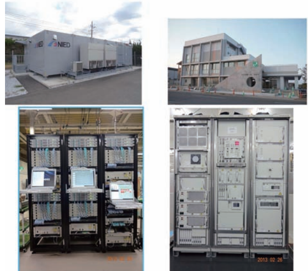
図5 陸上局の概要 左上：震度7に耐えるコンテナ型陸上局、右上：亶理陸上局(“きずなぼーとわたり”3階)、左下：光伝送装置等の陸上端局装置、右下：高圧給電装置
