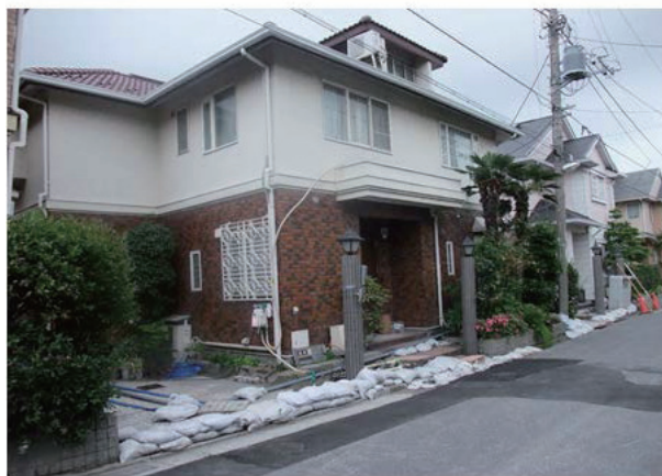
写真1 液状化によって被災した住宅
