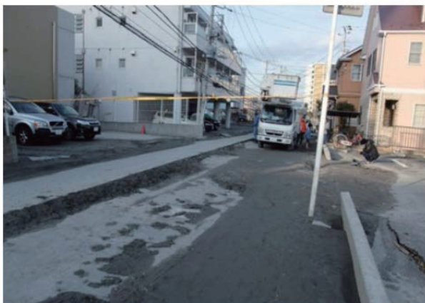
写真2 浦安市で突き上げた道路
