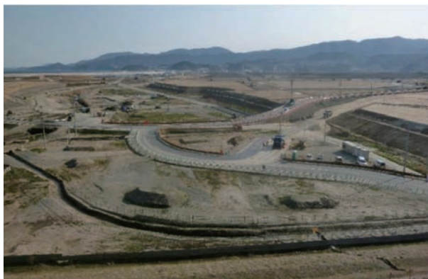
写真3 現在の市街地の中心である高田地区の造成工事の様子(左上の白いラインは写真1の防潮堤) (著者撮影)
