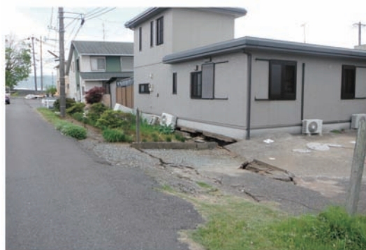
写真4 2016年熊本地震で発生した住宅地の液状化被害
