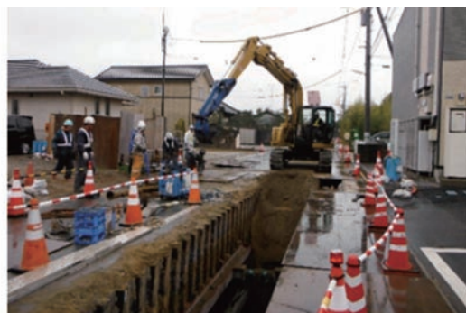
写真3 神栖市における暗渠排水管設置状況
