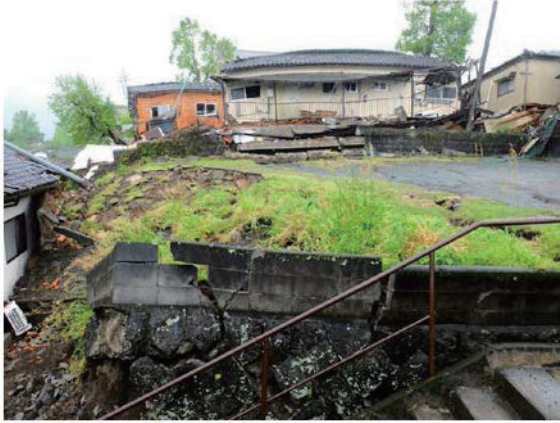
写真5 益城町中心部に発生した小規模地すべり
