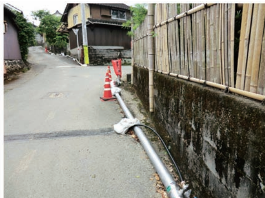
図6 路上の仮設配管の様子 (益城町下陣、2016年6月7日撮影)
