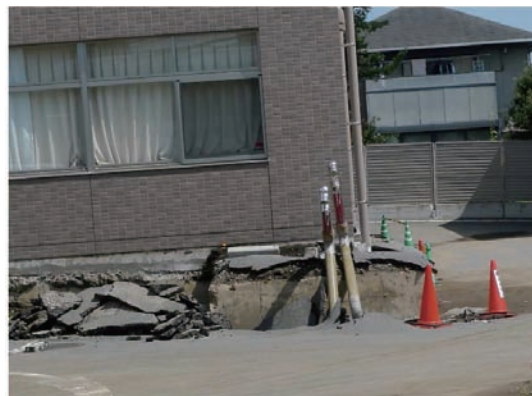
写真3 5階建てRC建物の基礎の抜け上がり(熊本市南区近見1丁目)
