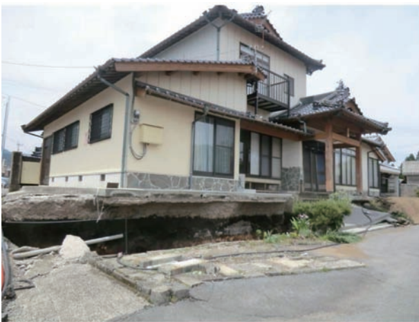
写真10 阿蘇市狩尾(山崎)における原因不明の地盤沈下による住宅被害(図5の③)
