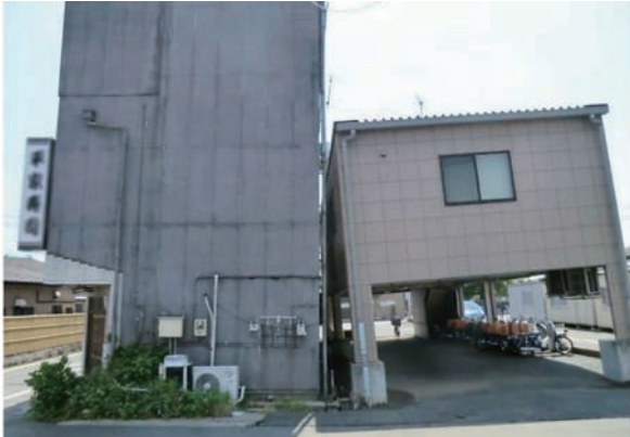
写真5 建物の傾斜(熊本市南区刈草1丁目)
