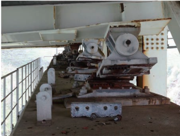
図3 並柳橋の支承の被災状況(4月24日撮影)
