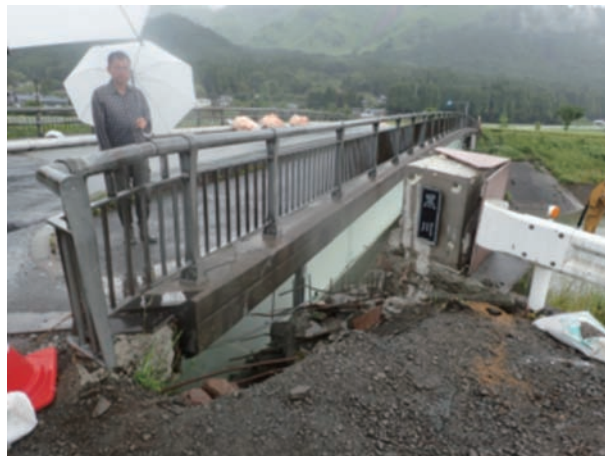
写真5 大正橋左岸取付け部。手前の地盤が奥に移動し、橋台部のパラペットが破壊された。移動量は約2m(2016.6.2北向きに撮影:吉見雅行)。
