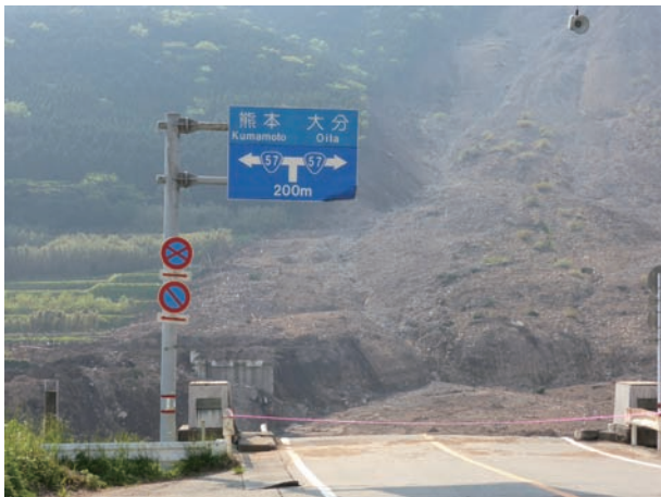
図4 橋梁が流出した阿蘇大橋(5月2日撮影)
