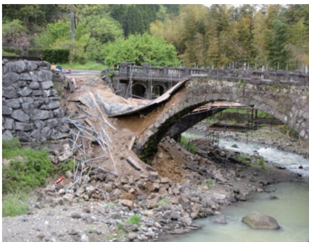
図9 二俣橋(福良渡)の壁石崩壊状況(4月18日撮影)
