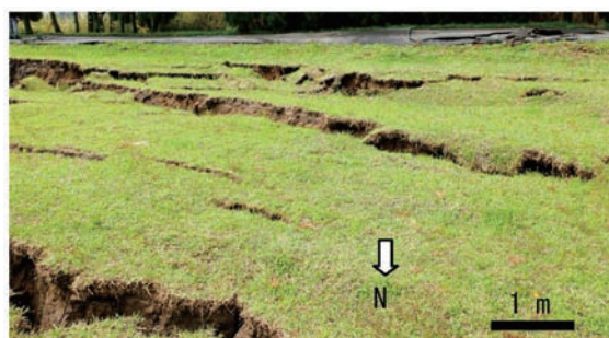
写真2 溶岩円頂丘頂部に形成された引張亀裂
