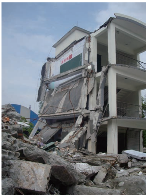
写真2 四川大地震で倒壊したRC3階建の中学校校舎。教室はすべて崩壊し、校舎中央の階段室だけが残った。(四川省都江堰市/入江撮影)
