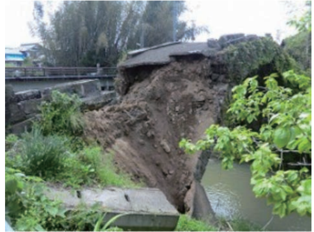
図7 安見下鶴橋の壁石崩壊状況（4月26日撮影）
