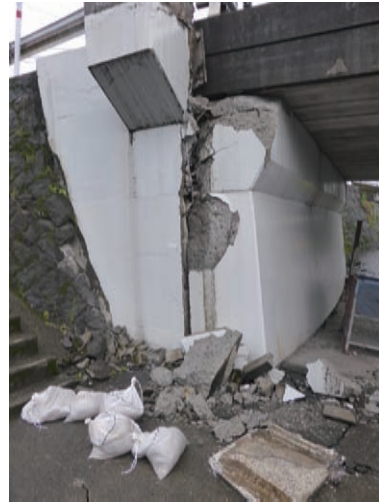
図5 寺迫橋橋台の被害(5月2日撮影)
