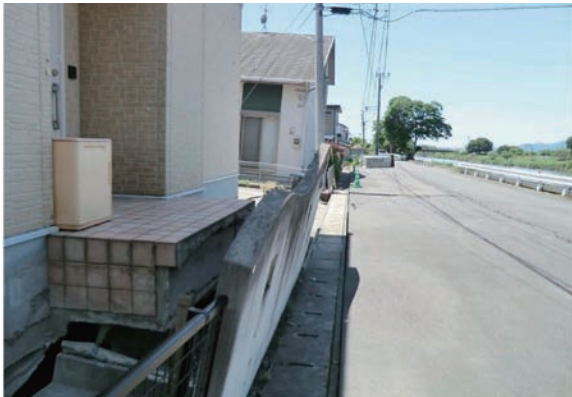
写真6 住宅の沈下(熊本市東区秋津町間島団地)
