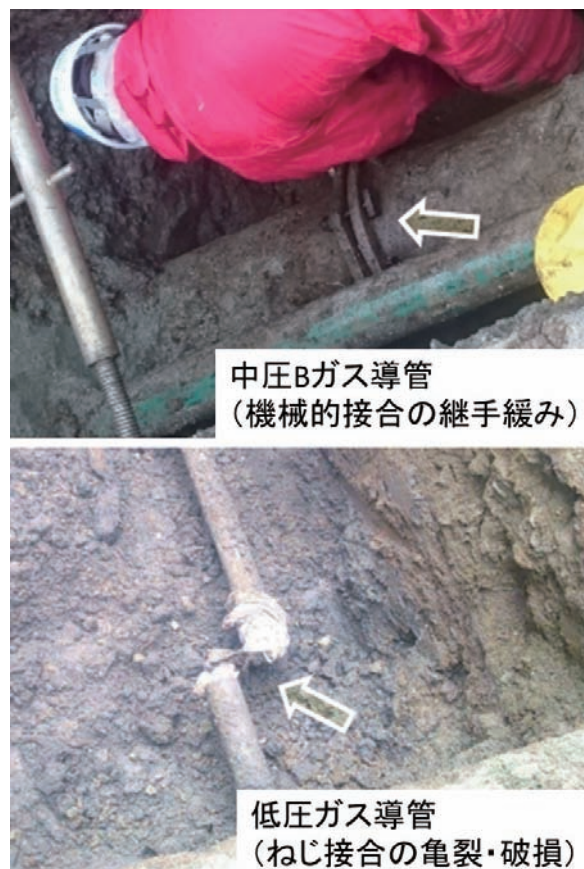
図9 ガス導管の被害状況 11)
