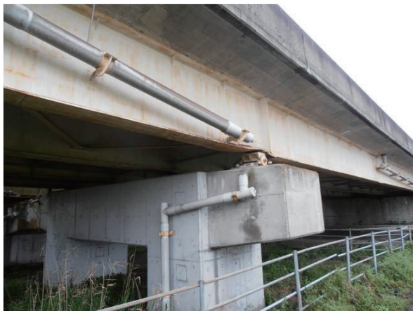
図1 木山川橋の被災状況(4月24日撮影)
