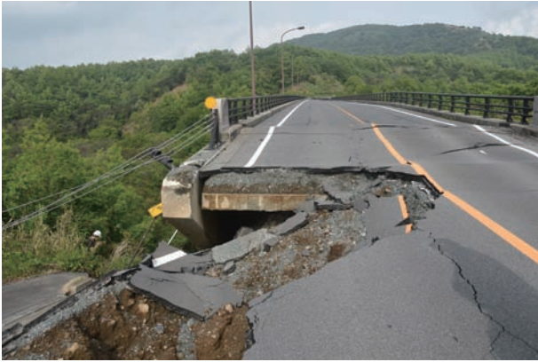
図6 俵山大橋橋梁端部の被害（5月7日撮影）
