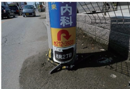
写真4 電柱の沈下(熊本市南区近見2丁目)
