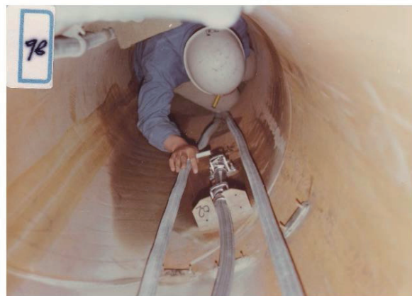
写真2 杭内のひずみ計取り付け
