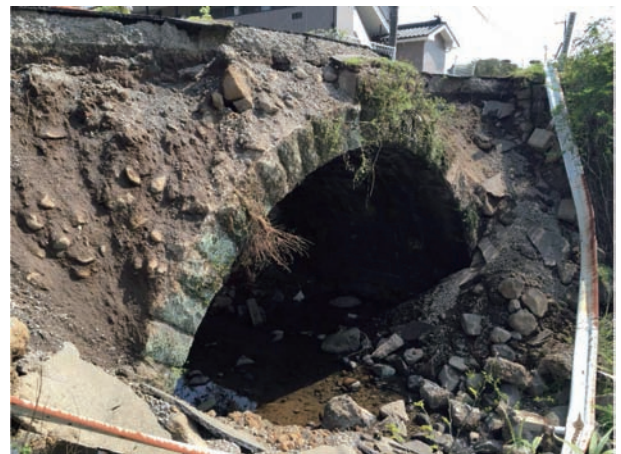
図8 銭瓶橋の壁石崩壊状況（7月6日撮影）
