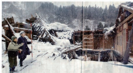
写真1 豪雪による家の破壊調査
