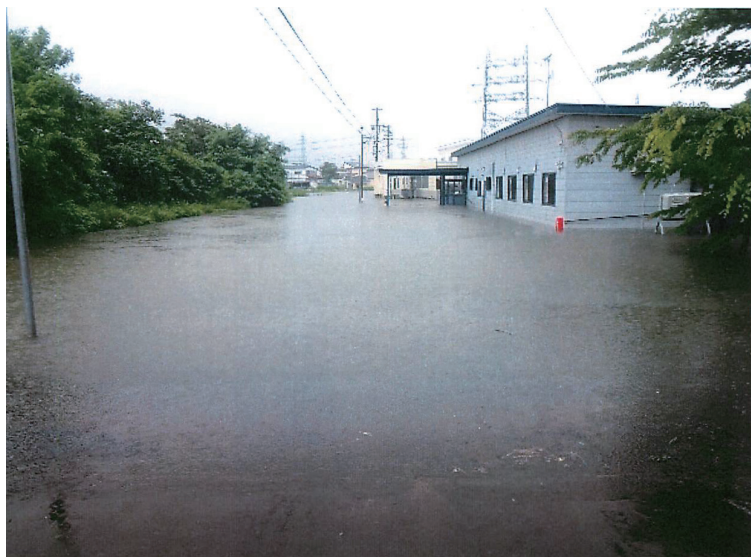
水に浸かった介護施設周辺
