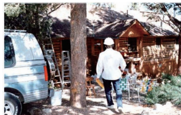
図2 米国における応急危険度判定の様子
