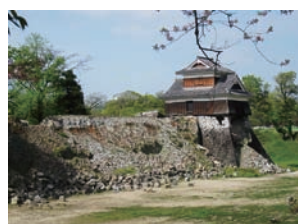
写真7 いぬい 戌亥櫓の石垣被害
