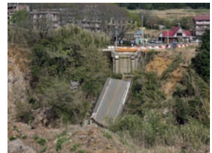
写真16 阿蘇大橋の被害
