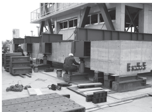
写真4 試験体のジャッキアップ
