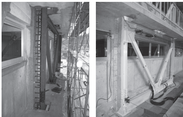
写真7 外付けブレース (既往詳細)
