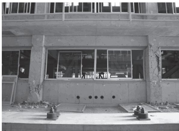
写真10 既存RC試験体の破壊状況(教室側)
