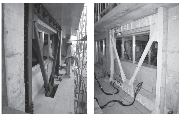
写真8 ソトルケブレース (新詳細)
