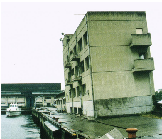
写真1 建物の被災状況 8)
