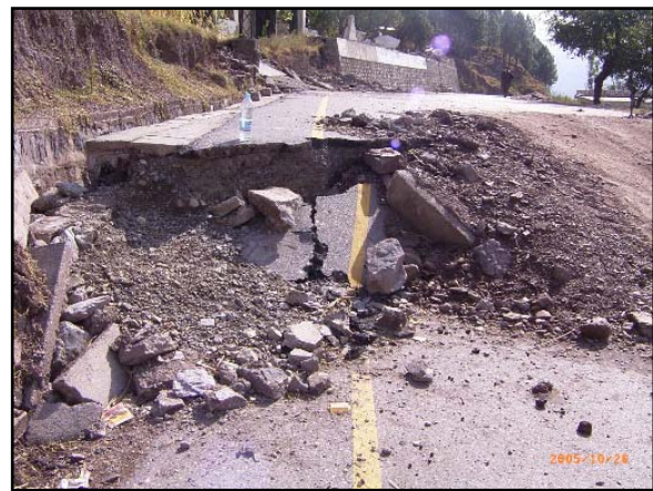
写真 24 道路に生じた段差
