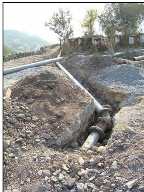
写真 32 修復中の水道管
