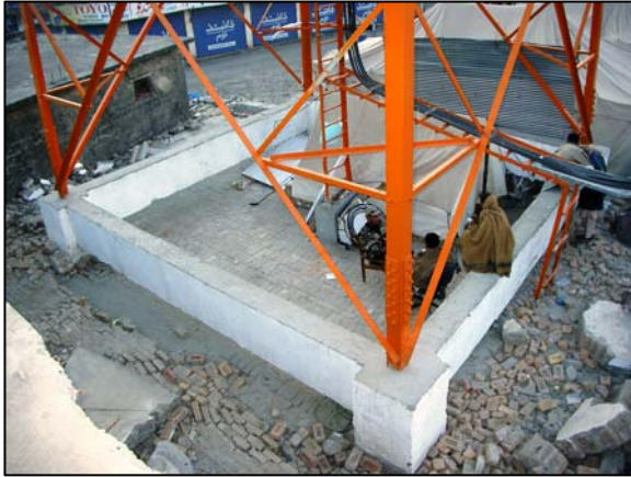
写真 21 鉄塔基礎の様子 (Kunhar 川右岸)
