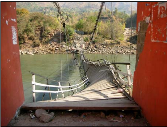
写真 38 落橋した吊橋
