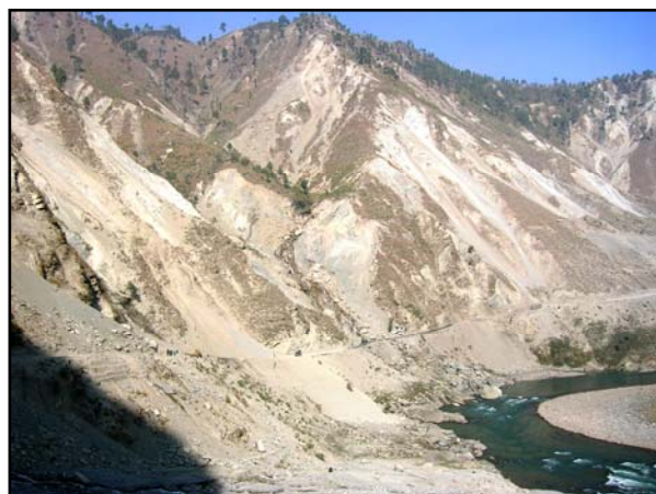
写真 43 多数の斜面崩壊
