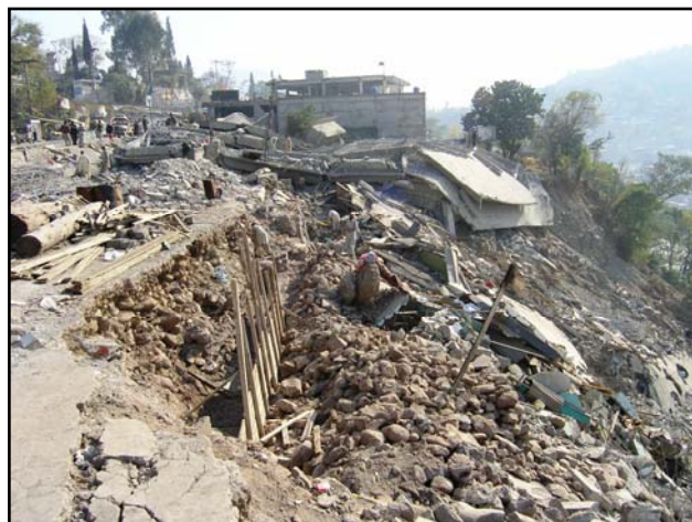
写真 27 Nilam 川左岸の斜面崩壊
