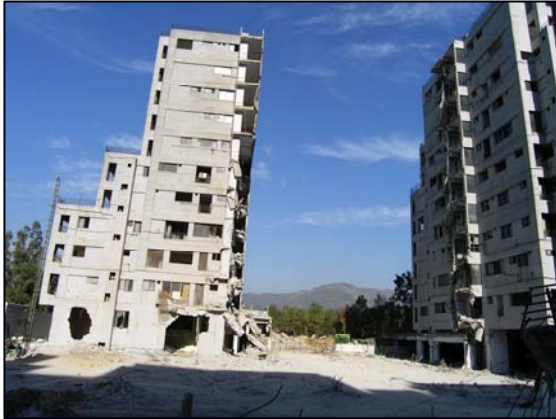
写真1 崩壊したマルガラタワー第4棟部
