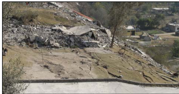
写真 35 斜面上に生じた亀裂
