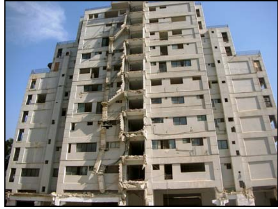
写真2 マルガラタワー第3棟部
