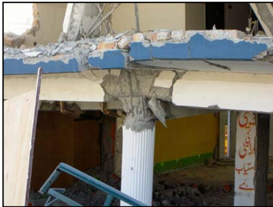
写真7 柱と床版接合部の損傷
