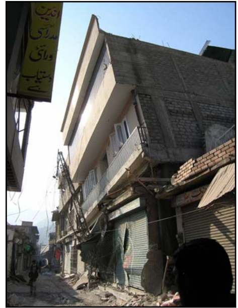
写真 29 不適切な構造の建物
