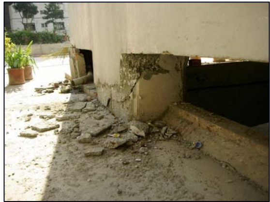
写真4 基礎の損傷
