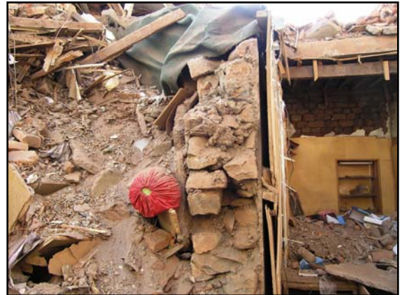
写真 31 無補強壁構造のダメージ 2
