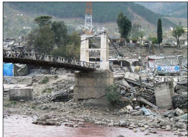
写真11 歩道つり橋の被害
