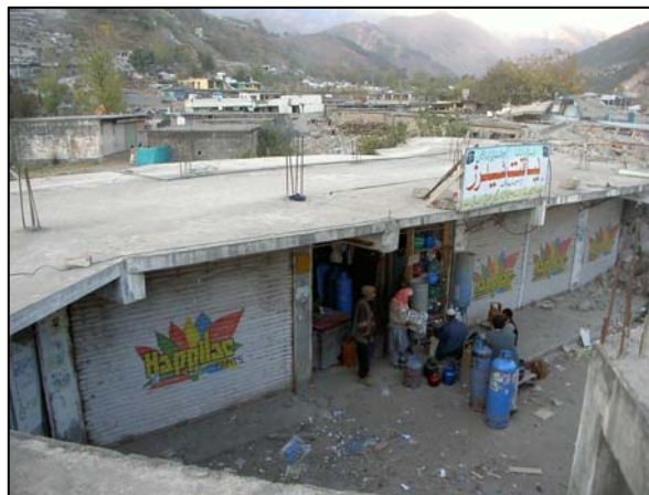
写真15 倒壊を免れた平屋家屋
