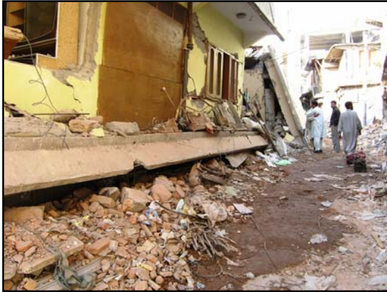
写真 28 一階が押しつぶされた建物
