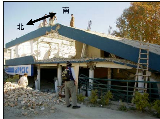
写真6 写真5のホテルの北側(地下部崩壊)
