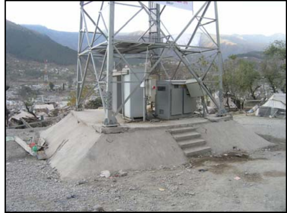
写真 22 鉄塔基礎の様子 (Kunhar 川左岸)
