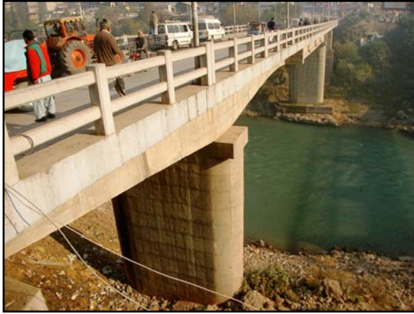
写真 36 無被害のコンクリート橋
