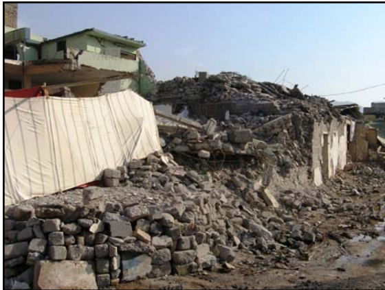
写真 30 無補強壁構造のダメージ 1
