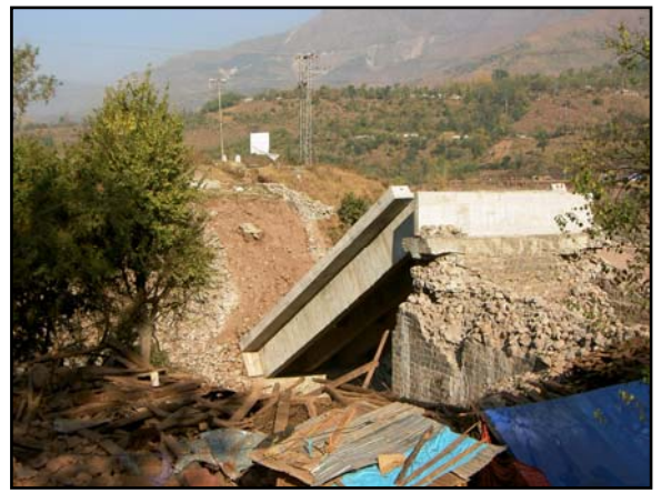
写真 39 落橋した建設途中の橋
