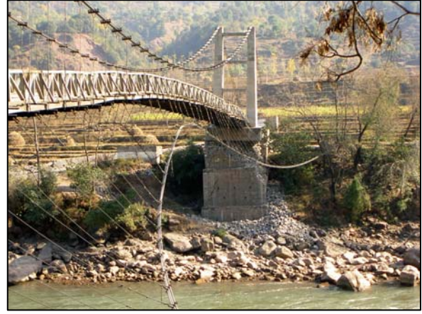
写真 37 橋台基礎に損傷を受けた吊橋
