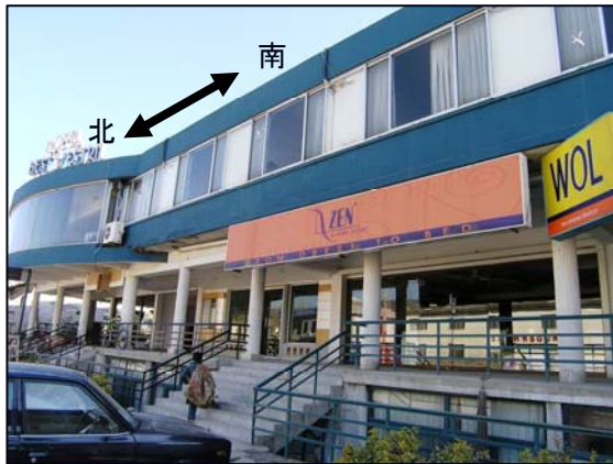
写真5 ダメージを受けたホテルの南側(無被害)
