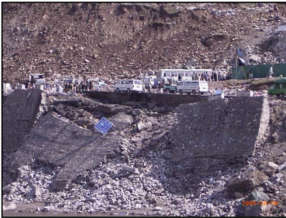
写真 25 擁壁の崩壊
