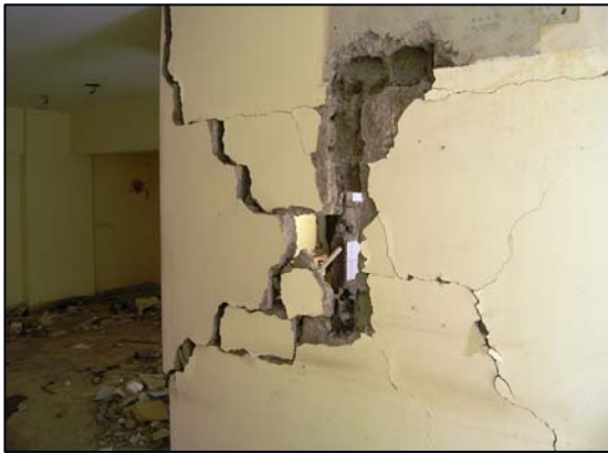
写真3 無補強壁の崩壊状況
