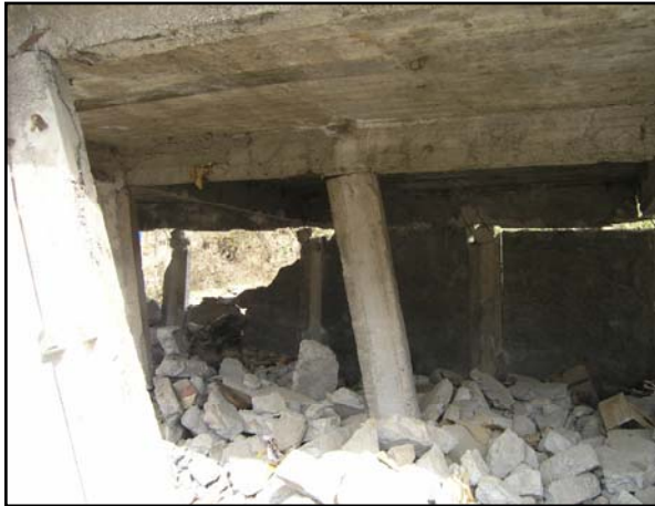
写真13 被災した建物内部の様子
