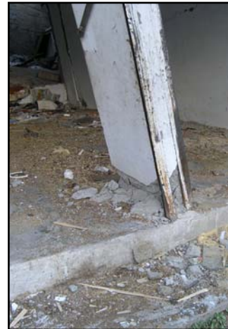
写真14 下端部で曲がった柱
