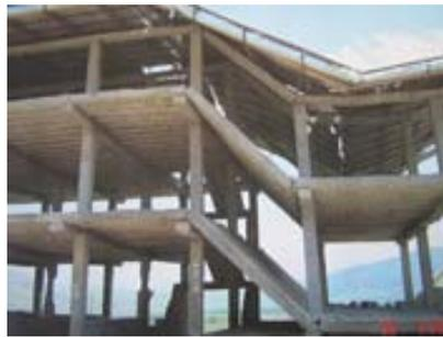
写真 7 1階柱の崩壊による
