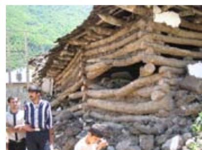
写真 5 丸太建物の破損
