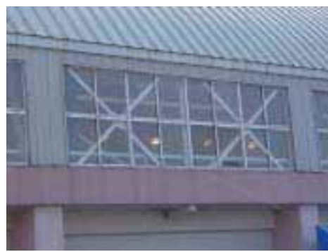
写真35 元々のXブレースの他にVブレースの補強がされている。
