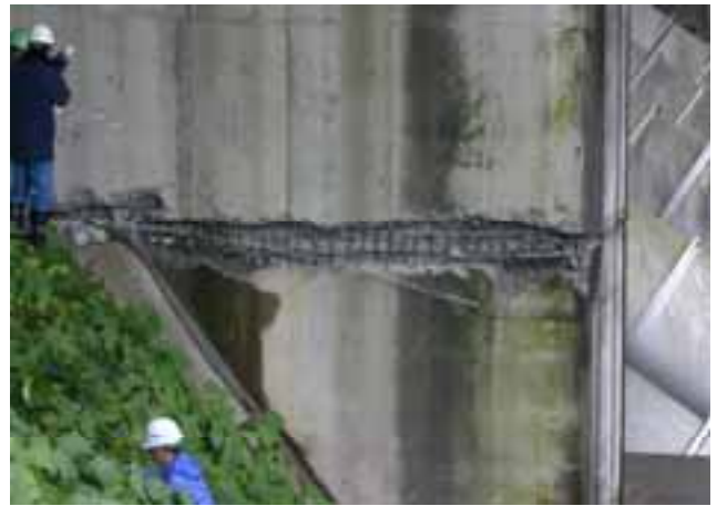
写真5 国道117号山辺橋（壁式橋脚かぶりコンクリートの剥落、軸方向鉄筋のはらみ出し）
