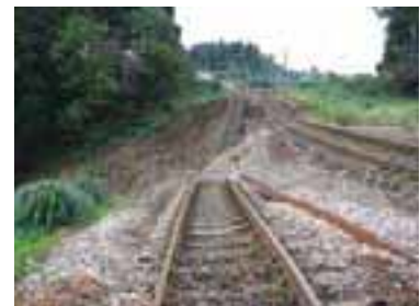
221k950~100m付近盛土崩壊
