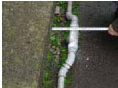
(b) 融雪装置配管 凸形ジョイント部が建物と接触したようである。
