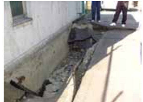
写真20 佐藤池運動広場クラブハウス周囲の沈下(宮山陽子氏提供)
