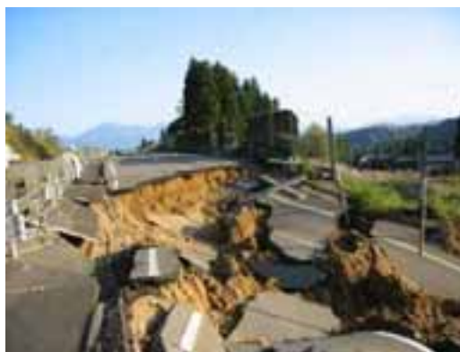
写真9 斜面崩壊・竜光 B (日本道路公団)
