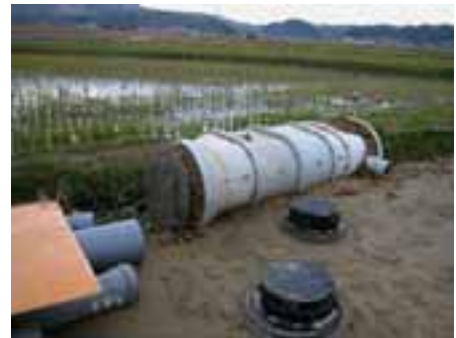
写真14 小千谷市上村におけるFRP製マンホールの浮上・転倒
