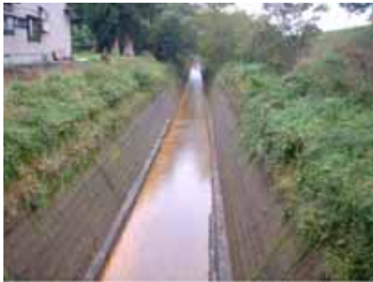
(b) 川裏側のり尻の水路（変状は認められない）
