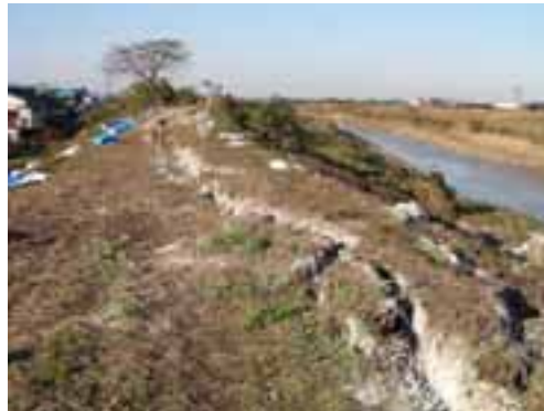
写真5 刈谷田川・中之島の堤体損傷
