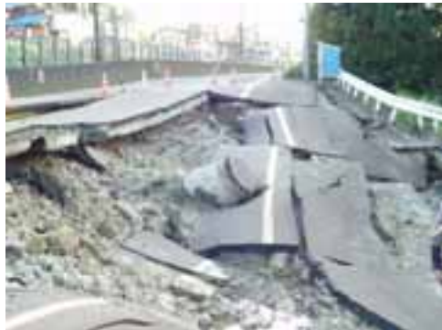
写真4 国道291号・東栄の崩壊
