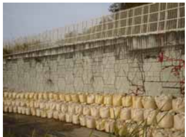
写真13 関越自動車道堀之内ICの補強工擁壁 (壁面のはらみ出し、壁面材の傾斜と破損)
