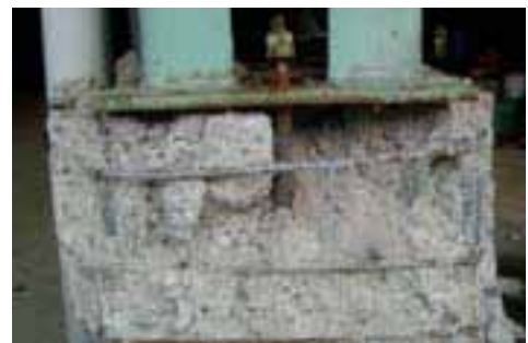
写真33 長岡市の事務所兼住宅(建物C)の柱脚の被害
