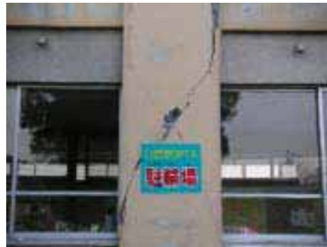
写真4 東小千谷小学校 (北棟) の1階の柱のせん断破壊
