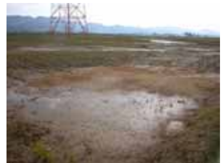
写真8 砂利採掘跡地の埋め戻し地盤における噴砂
