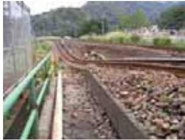
48k400～700m付近築堤崩壊
