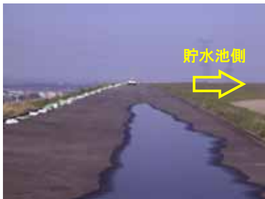
写真 9 天端舗装面の傾斜
