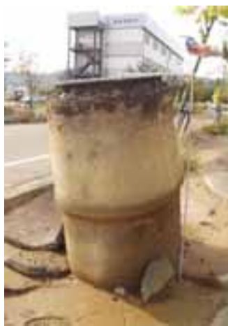
写真1 若葉地区(図2のA)で1mほど浮き上がったマンホール
