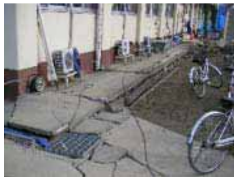
写真2 田麦山小学校の周辺地盤の変状
