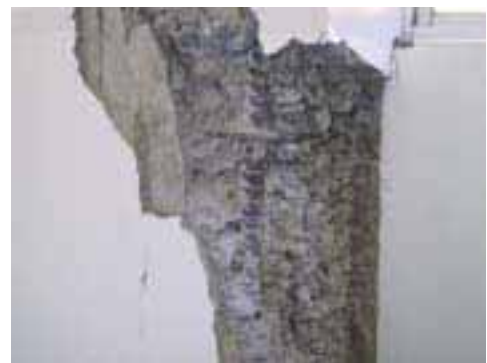
写真22 写真21の詳細（ジャンカが認められる）
