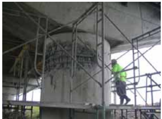
写真1 国道8号新組跨線橋 (かぶりコンクリートの剥落、軸方向鉄筋のはらみ出し)
