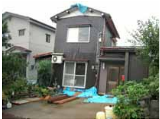
写真26 崖崩れによって大きく傾いた家屋
