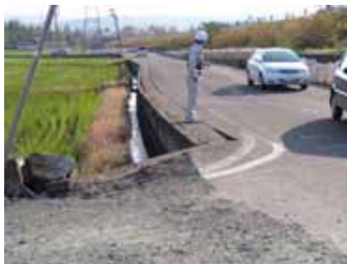
写真7 側道の変形
