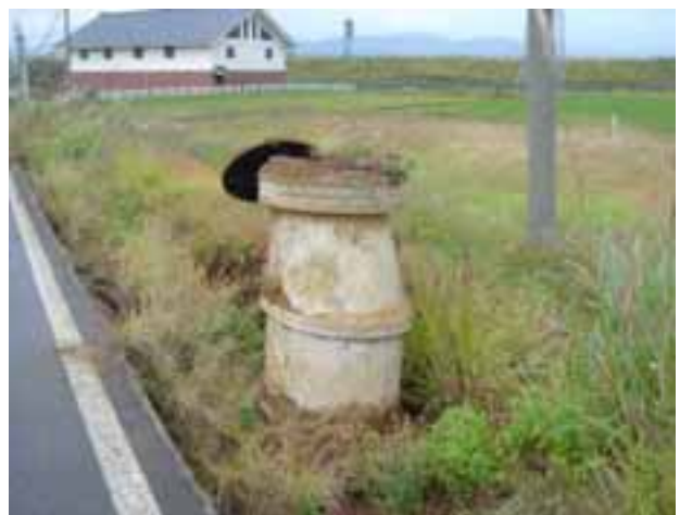
写真2 打越地区(図2のB)で浮き上がったマンホール
