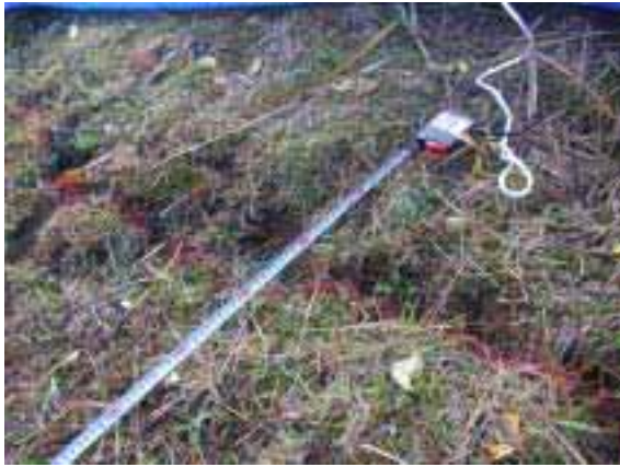
写真3 坪山ダム、下流斜面のクラック
