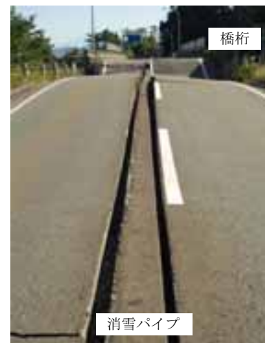
写真1 跨線橋(越路町)
