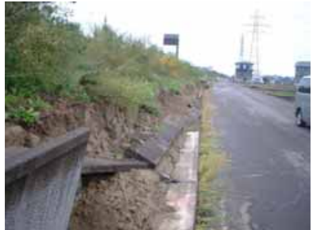
写真12 関越自動車道小千谷IC付近のL型擁壁 (擁壁前面への滑動と転倒、たて壁の破損)
