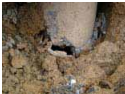
写真15 写真14の右の杭の詳細。PC 杭で 350。中空部とコンクリートが充填してある杭頭補強部の境でせん断破壊。
