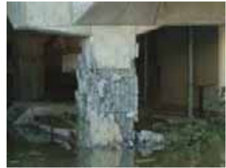
写真 1 損傷状況（第一和南津高架橋）
