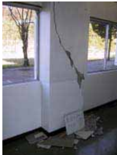
写真21 栃尾市東谷小学校の柱のせん断破壊
