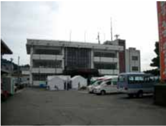
写真37 川口町震度計の脇の役場建物
