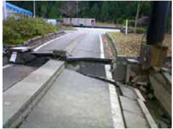
写真18 堀ノ内浄化センター管理棟アプローチの変状
