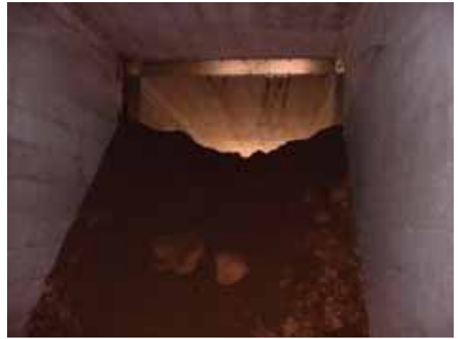
写真11 関越自動車道小千谷IC付近のカルバート (函体目地部が開いて裏込め土が流入)
