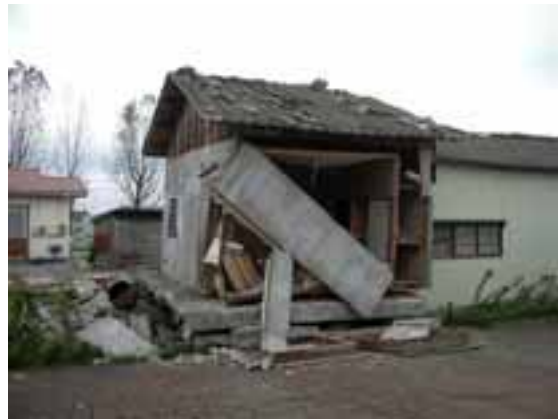
写真4 全壊した木造建物
