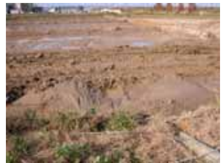
写真12 埋戻し地盤における噴砂
