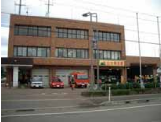
写真1 JMA 小千谷の脇にある消防署建物
