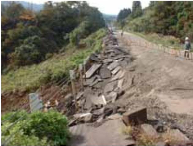
写真8 国道117号小千谷市塩殿 (谷部を横断する高さ約30mの盛土)
