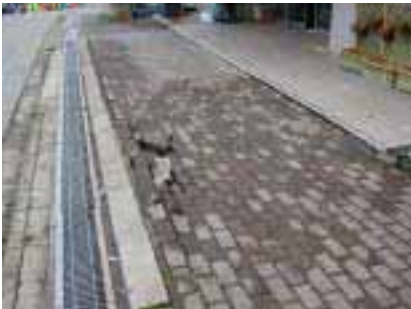
(a) エントランス 車いす対応のため段差なしで設計。砂締めインターロッキングが建物に押されて浮き上がる。
