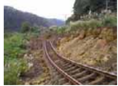
54k800m付近築堤崩壊
