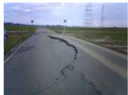
写真7 砂利未採掘地点における農道の被害と水田の噴砂。鉄塔の向こう側で砂利の採掘が行われた。
