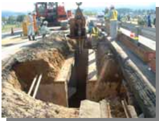
写真6 ボックスカルバートの開口（日本道路公団）
