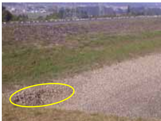
写真 11 貯水池側のり面リップラップの段差
