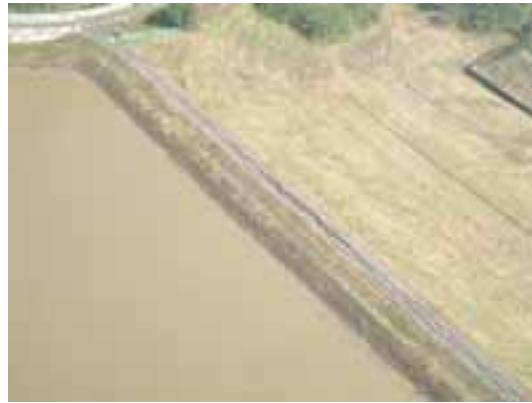
写真8 地震後の水位上昇（北陸地方整備局撮影）
