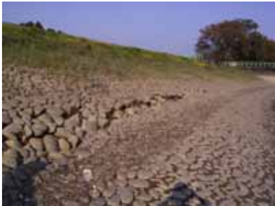
写真 13 貯水池側のり面のすべり変状写真
