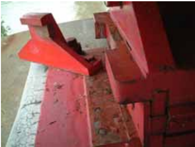
写真3 国道17号小千谷大橋 （可動支承のサイドブロックの損傷）
