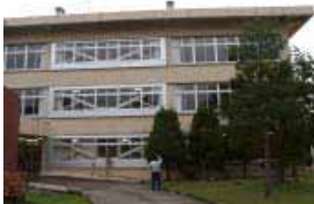
写真8 十日町総合高校管理棟
