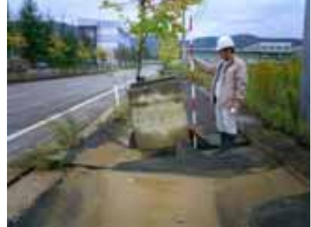
写真13 小千谷市若葉町におけるマンホールの浮上
