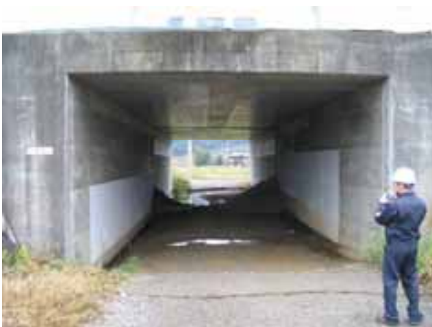
写真10 関越自動車道小千谷IC付近のカルバート (カルバート函体が約30cm沈下)
