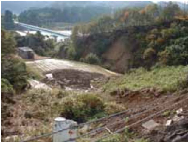
写真9 国道117号小千谷市塩殿 (滑り土塊の先端 がのり尻から約30m先まで流れるように崩壊)
