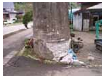
写真 10 損傷状況（魚野川橋りょう 17P）
