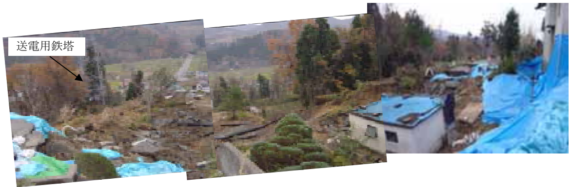
写真13 高町団地・崩壊地点 E
