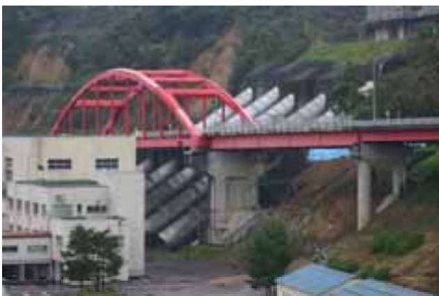
写真4 国道117号山辺橋 （JR発電所の導水管を跨いで斜面上に位置する）
