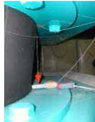
(c) 積層ゴムの残留変形 簡易な測定であるが、3cm 程度の変形が認められる。
