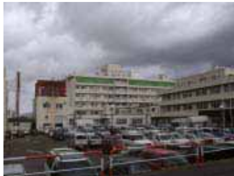
写真25 十日町病院の全景 (中央が病棟)
