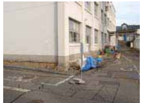
写真20 長岡工専3号館の地盤沈下による基礎の露出（右が崖地）
