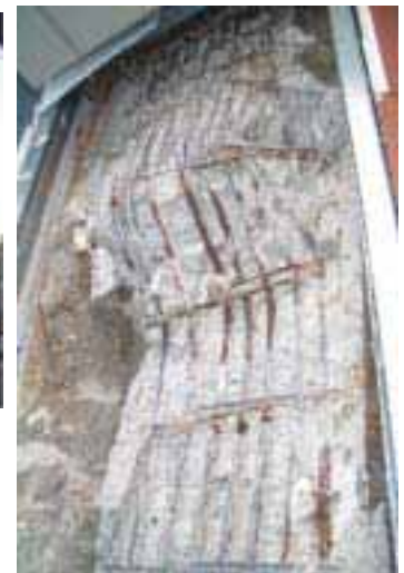
写真30 建物Bの柱のせん断破壊「梶井照仁氏(建築構造研究所)撮影」
