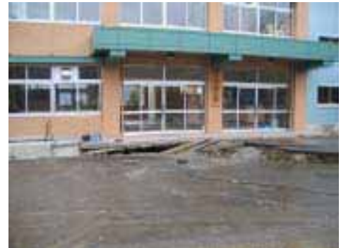
写真19 山古志中学校校舎棟の南面。左（西）側に向かって断続的に地盤沈下
