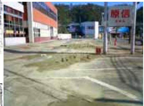
写真2 見附市南本町2丁目の駐車場で の噴砂とアスファルトの波打ち
