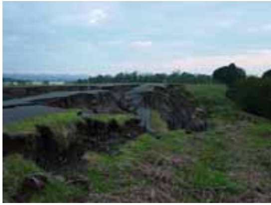
(a) 川裏側のり面のすべり崩壊（北陸地整撮影）
