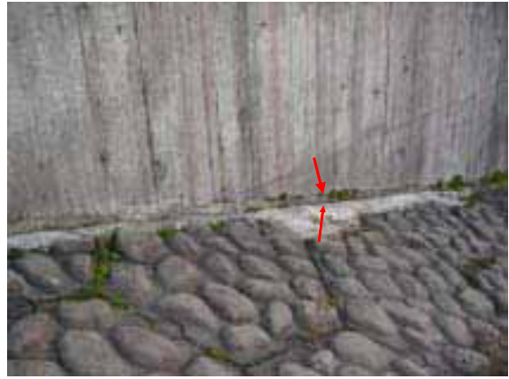
写真4 坪山ダム、洪水吐と張りブロック間の沈下(約7cm)
