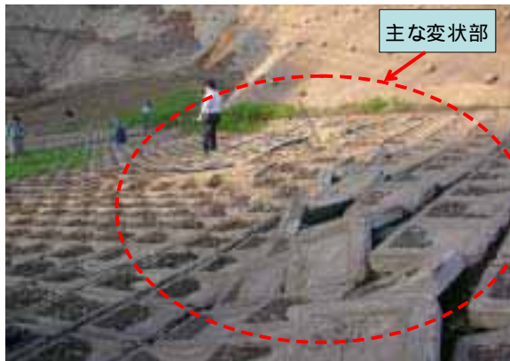
写真5 川西ダム、上流斜面の変状
