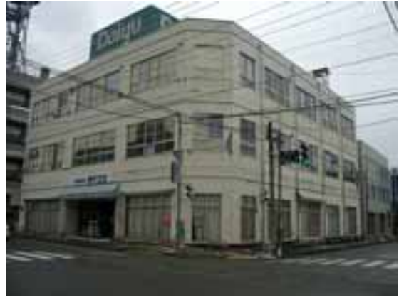
写真18 非構造部材が大きな被害を受けた鉄骨造建物
