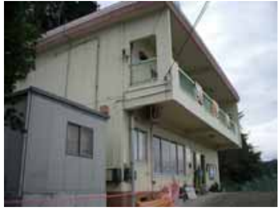
写真36 非構造壁にやや大きな被害が見られたRC造建物
