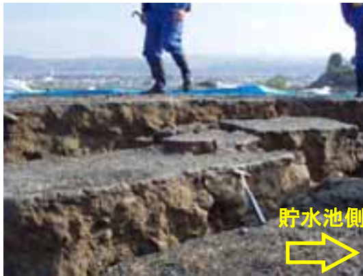
写真7 天端亀裂による段差
