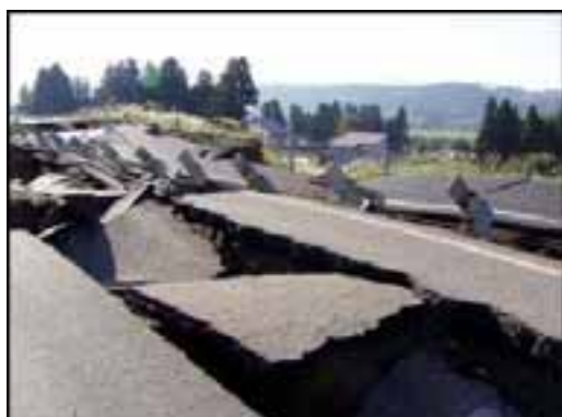
写真8 斜面崩壊・竜光 A (日本道路公団)
