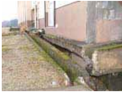
写真16 校舎棟の南西隅角部から北側をみる。向こうが体育館棟。校舎棟は体育館棟に比べ建物の傾斜が大きく。この部分の建物の不同沈下および地盤の沈下が最も大きい。
