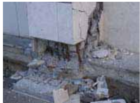
写真28 建物Aの柱脚の被害
