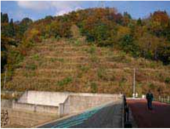
写真1 長福寺ダムの天端、洪水吐
