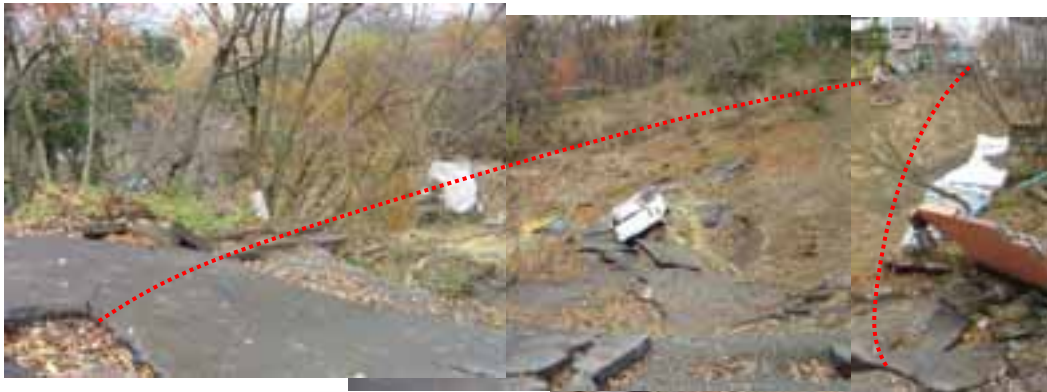
写真10 高町団地・斜面崩壊 A
