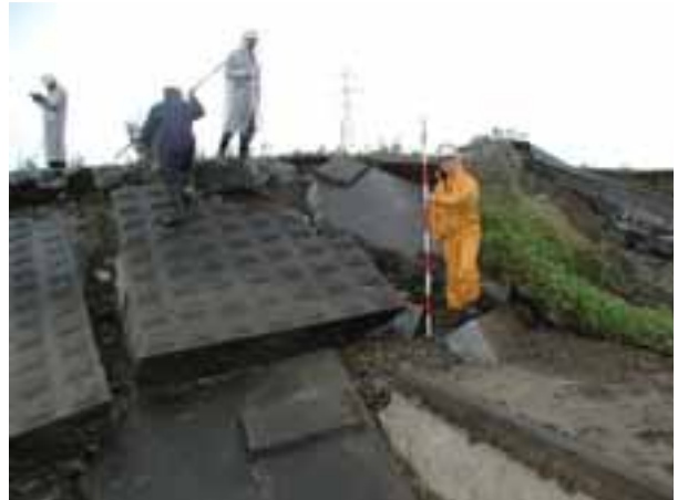
写真6 妙見堰付近の低水護岸の損壊
