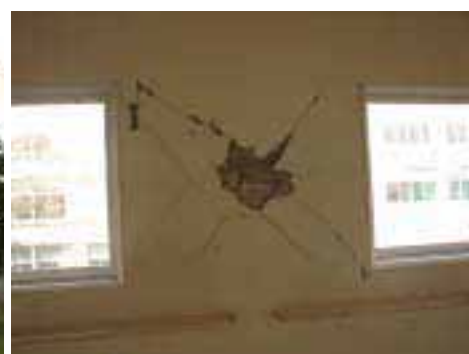
写真9 2F北側構面の柱のせん断破壊( )
