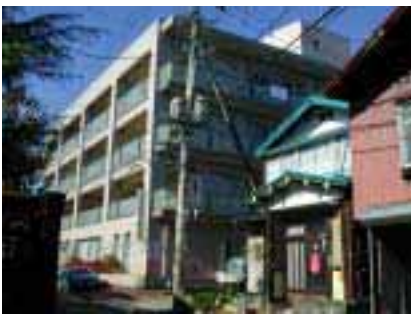
(a) 地震後の建物外観
