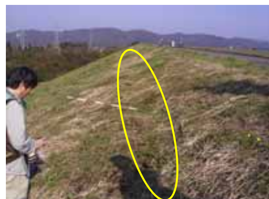
写真 10 貯水池外側のり面陥没および亀裂
