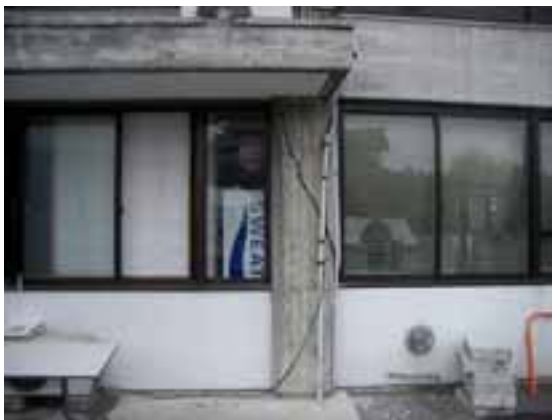
写真13 中里村役場建物の1階柱のせん断ひび割れ
