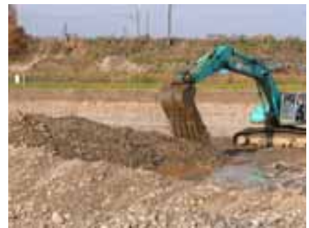
写真10 砂利掘削の状況
