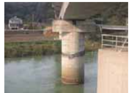
写真 3 損傷状況（魚野川橋りょう 2P）
