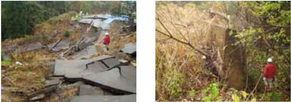
写真12 高町団地・崩壊地点 C
