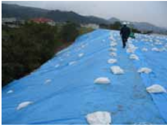
(c) 応急復旧の状況
