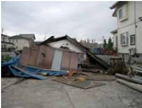
写真3 倒壊した木造建物
