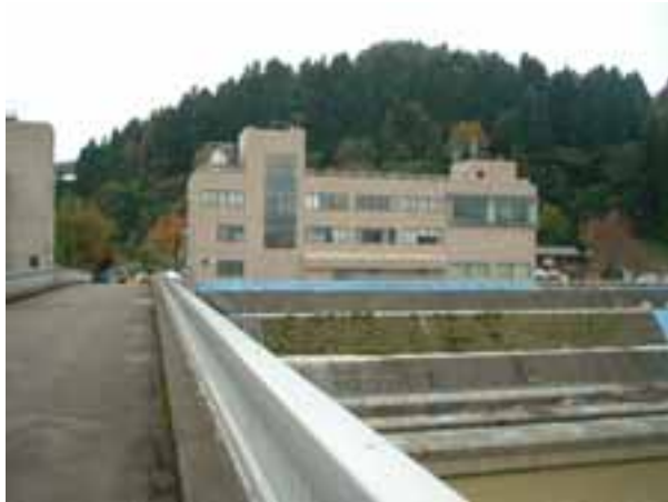
写真5 妙見堰管理所建物の傾斜 9.1-29.25km
