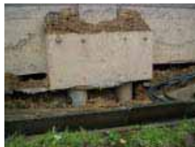
写真14 写真13の右から2番目の基礎。PC 杭(350、中空(厚さ75mm)、軸方向筋6 @130mm、横方向筋の径は約2.3mm)
