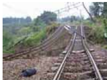
221k500~670m付近盛土崩壊
