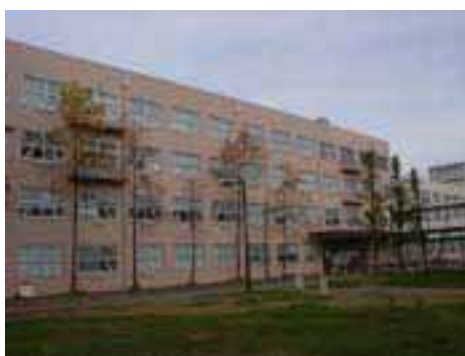
写真10 長岡高専4号館はKブレースにより補強がされていた
