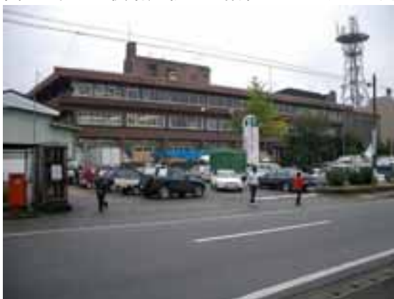
写真15 十日町市震度計の脇にある役場建物
