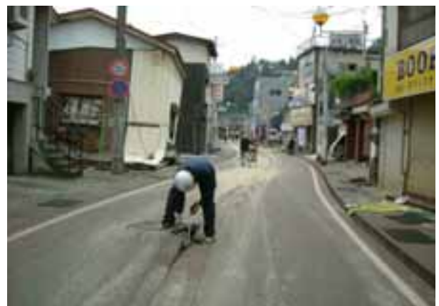
写真4 川口町におけるマンホールの浮上りと家屋の被災状況
