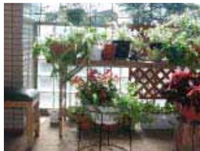
(e) 2階テラス 植栽プランターの落下は1個のみ。（床面に土跡あり）
