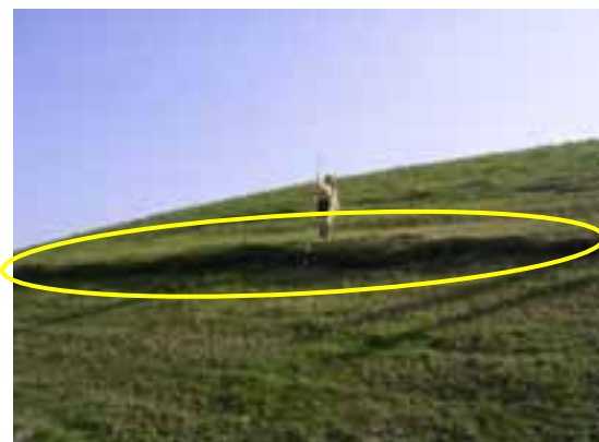
写真 12 貯水池外側のり面のはらみだし部
