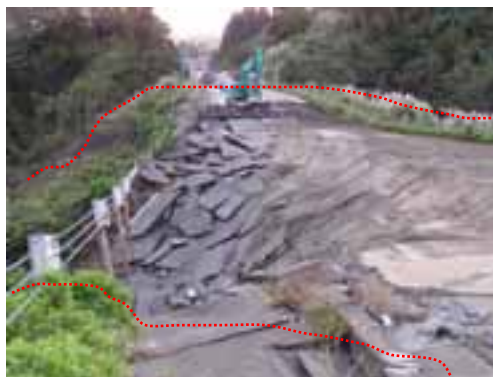
写真3 国道117号・塩殿の崩壊
