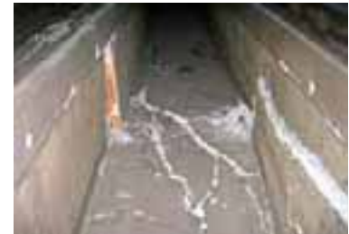
図3 魚沼トンネル被害状況
