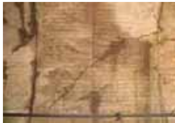
新榎峠トンネル（上り線） 覆工コンクリートひび割れ
