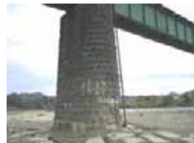
写真 9 損傷状況（魚野川橋りょう 9P）
