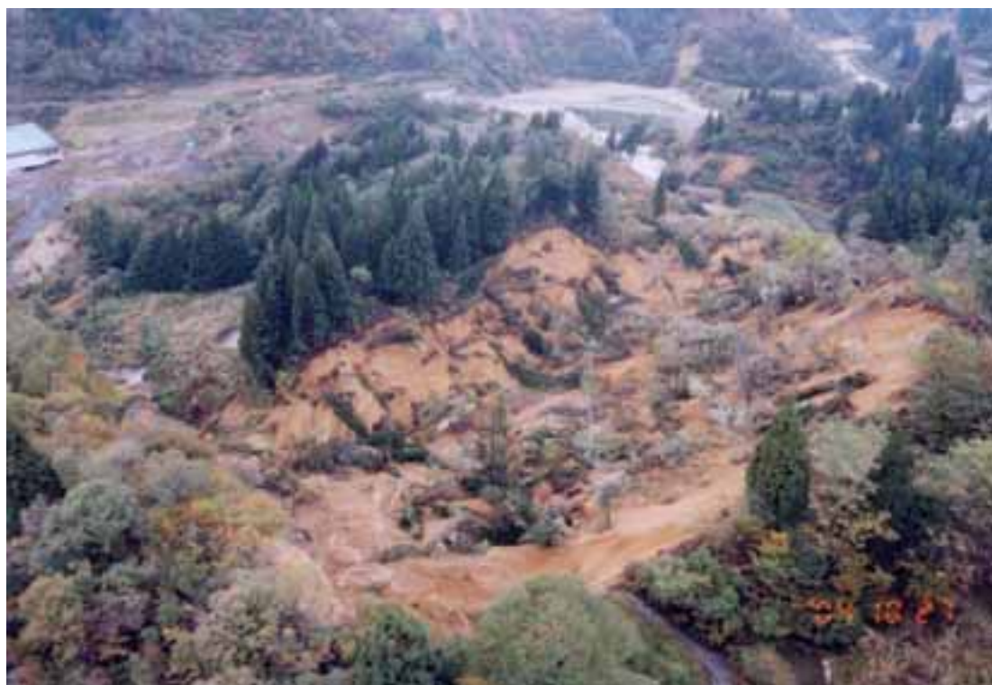
写真1 山古志村東竹沢地区の地すべり頭部の滑落崖。地すべり土塊は写真右下の滑落崖から左上の方向へ移動し、芋川を堰き止めた（10月27日撮影）
