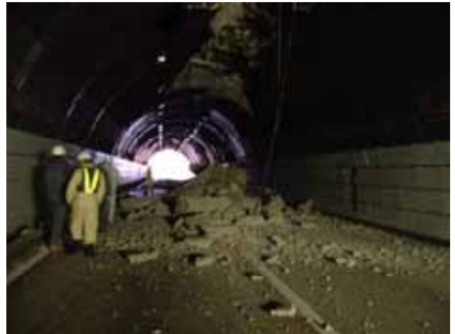
写真6 国道17号和南津トンネル（長岡側坑口より約100mの地点で覆工コンクリートが落下）
