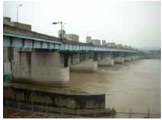
(a) 妙見堰全景（写真奥が左岸側 1 番ゲート）
