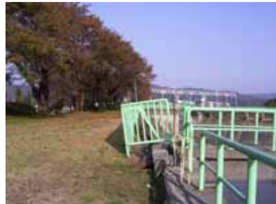
写真 14 取水設備周辺の地盤変状
