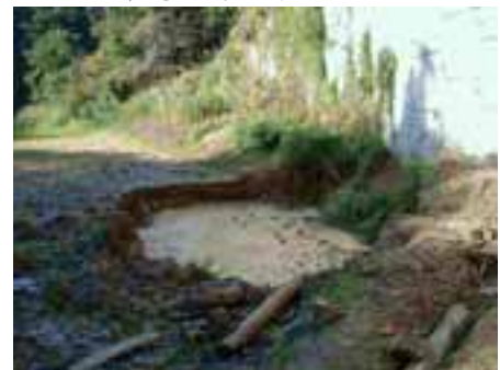
写真17 小千谷市稗生の水田に生じた陥没 6)
