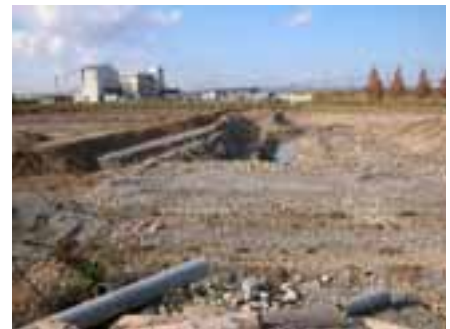
写真11 砂利採取後の埋戻しの状況
