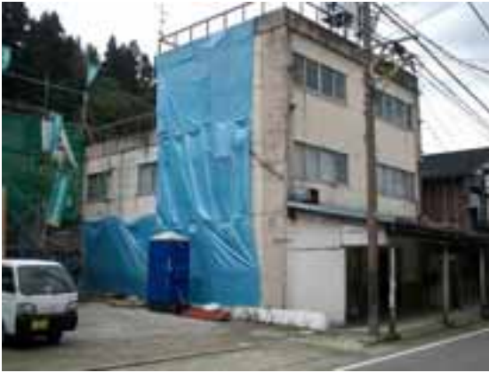
写真35 外壁が崩落した鉄骨造建物
