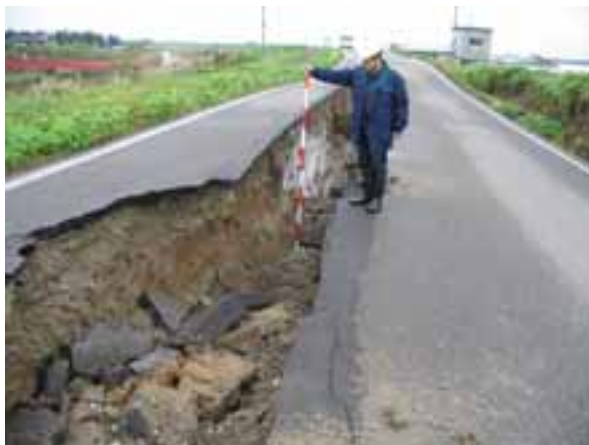
(a) 堤防天端の縦断亀裂と段差
