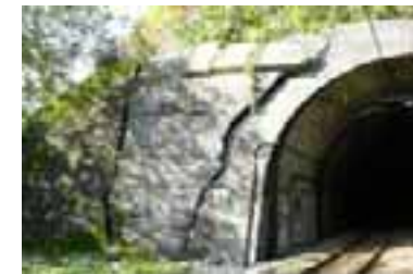
牛ヶ島トンネル 坑門損傷
