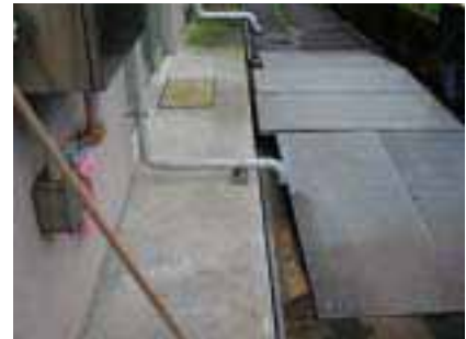
(c) 台車の搬入路 建物に押され移動。復旧は容易。
