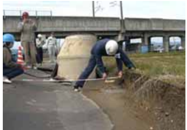
写真3 長岡市渡沢町におけるマンホールの浮上りと埋戻し部の沈下
