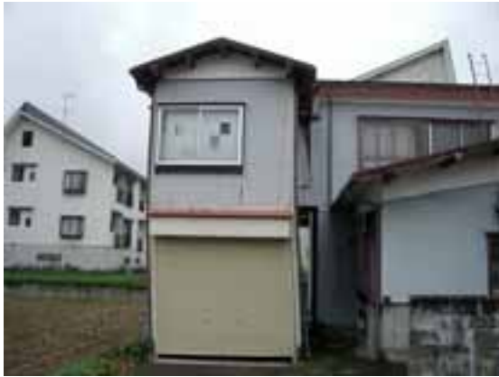
写真17 1階駐車スペースが傾いた家屋
