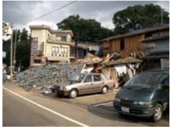
写真10 倒壊した木造倉庫建物
