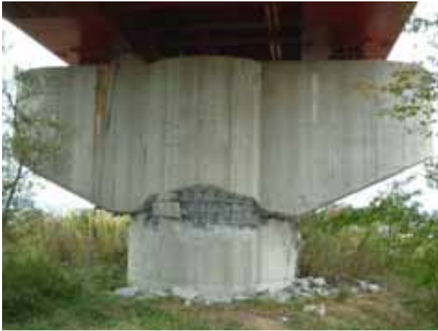
写真2 国道17号小千谷大橋（かぶりコンクリートの剥落、軸方向鉄筋のはらみ出し）
