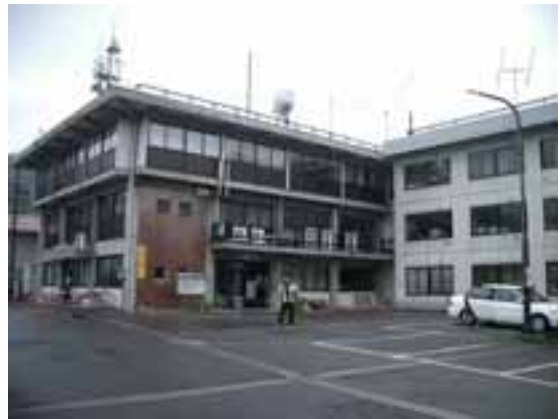
写真12 中里村震度計の脇にある役場建物
