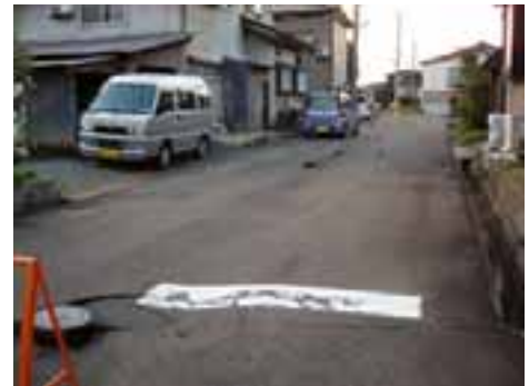
写真19 柏崎市半田2丁目における道路の沈下(宮山陽子氏提供)
