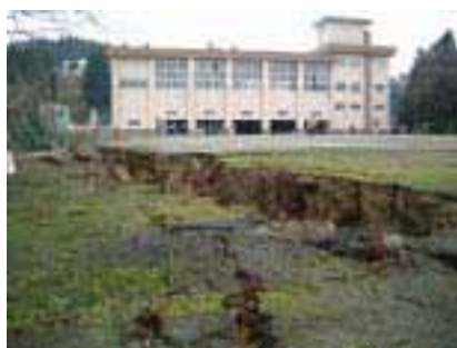
写真12 山古志小の全景を西から見る。右側が校舎棟。左側が体育館棟。両者は構造的に一体となっている。左右は崖地。
