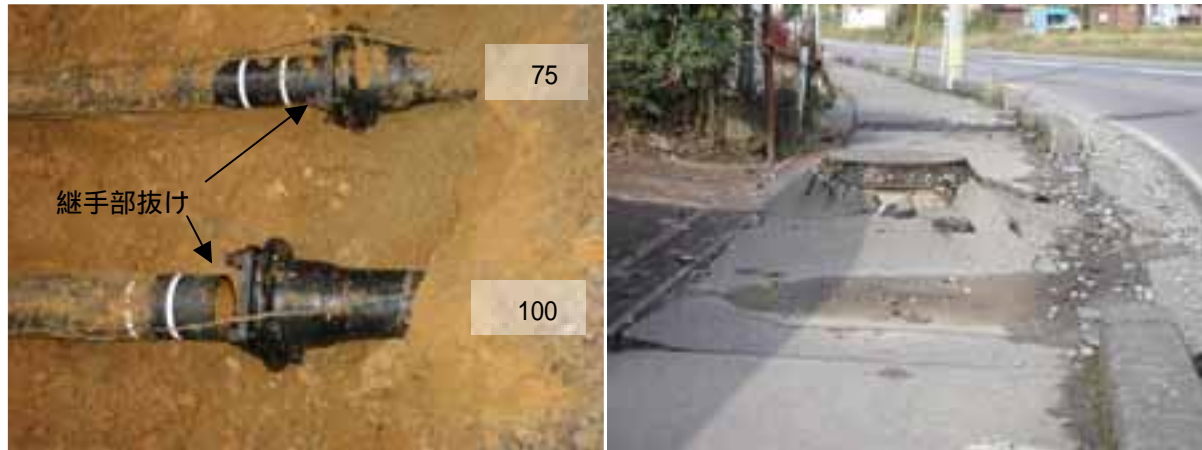
写真2 A形ダクタイトル鉄管の被害例 ( 100 および 75 継手部抜け )
