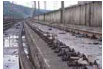
約900mにわたりレールが外れる 下り線 206k600m~207k500m
