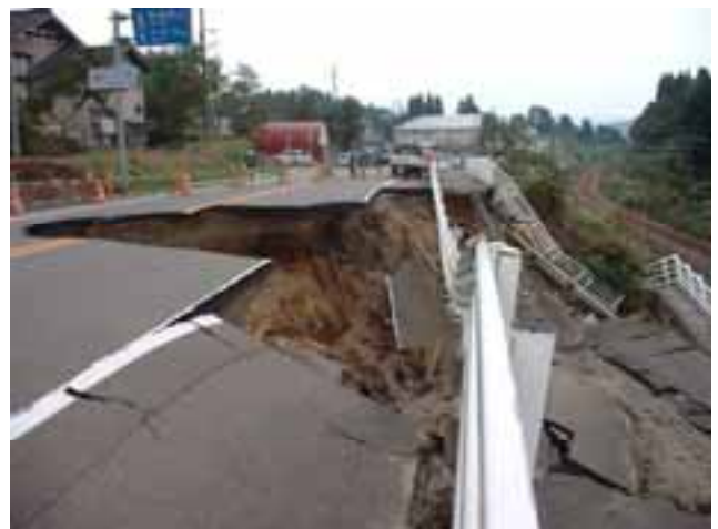
写真7 国道17号川口町天納（幅約40mにわたって盛土のり面が崩壊）
