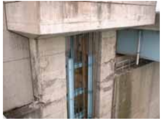
(c) 門柱部分の損傷
