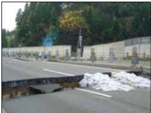
写真2 ボックスカルバートの段差 (日本道路公団)
