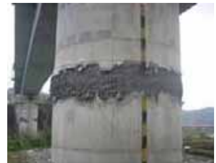
写真 4 損傷状況（魚野川橋りょう 3P）
