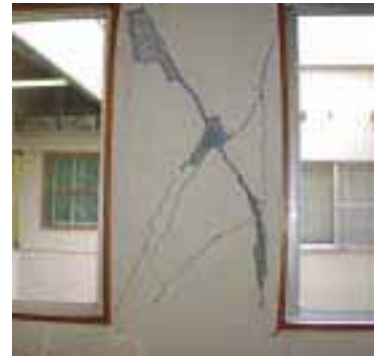
写真26 十日町病院の2F長辺方向柱のせん断破壊「高橋義道氏 (高橋構造企画設計) 撮影」
