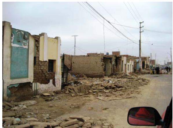
アドベ造が軒並み崩壊している地域もある
