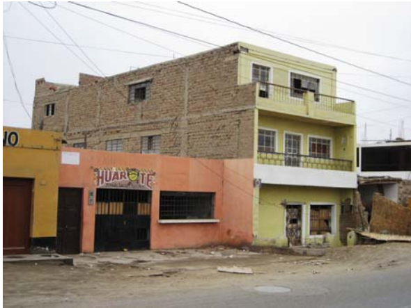
チンチャでは枠組み組積造の多くは被害無し
