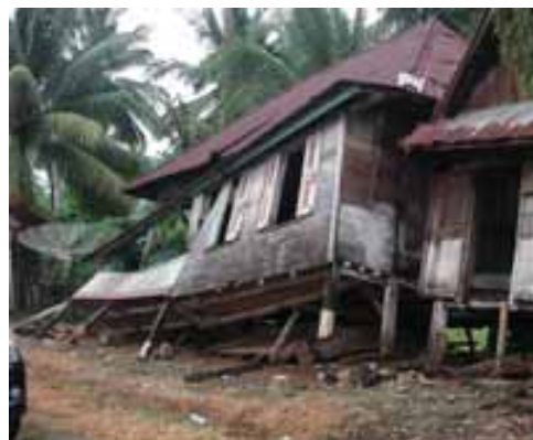
写真3 れんが積みおよび木造家屋の崩壊
