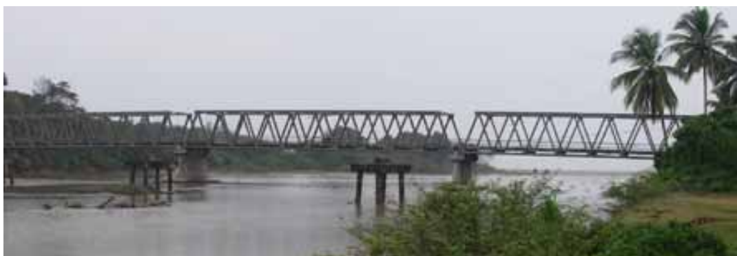
写真5 地盤の液状化に伴って不等沈下が発生した Seblat 川トラス橋
