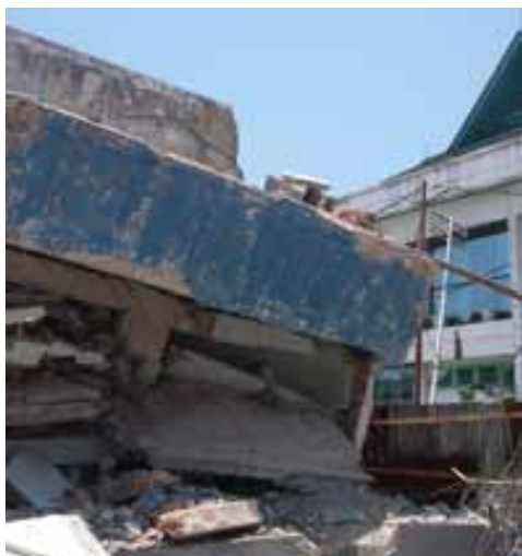
写真2 パダン市におけるRC構造物の崩壊
