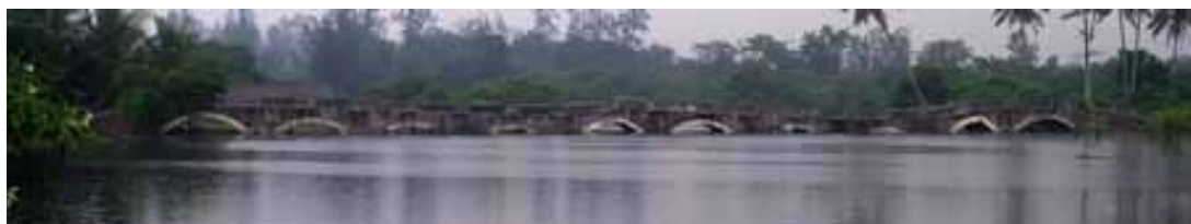
写真4 地盤の液状化に伴うアーチ橋の被害
