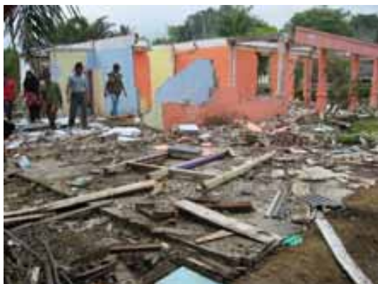
写真3 れんが積みおよび木造家屋の崩壊
