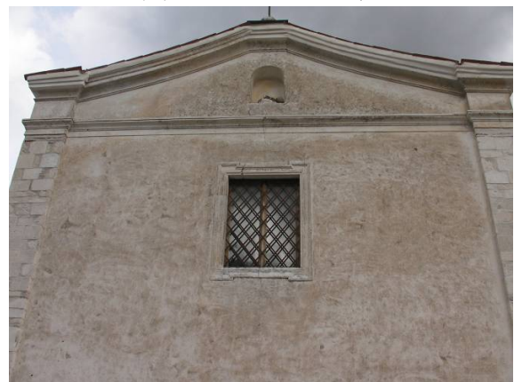
写真-130 ファサードのひび割れ
