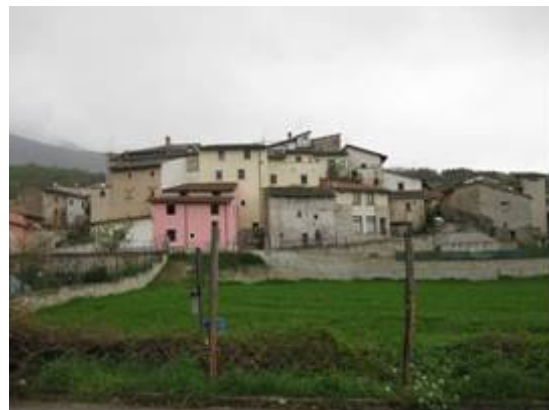
写真-82 城壁のような連結された住宅
