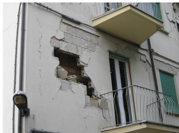
写真-68 空洞煉瓦壁を2重にして設置(5)
