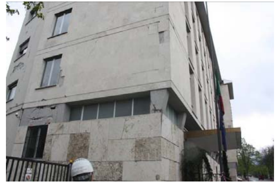
写真-60 短柱のせん断破壊(2)
