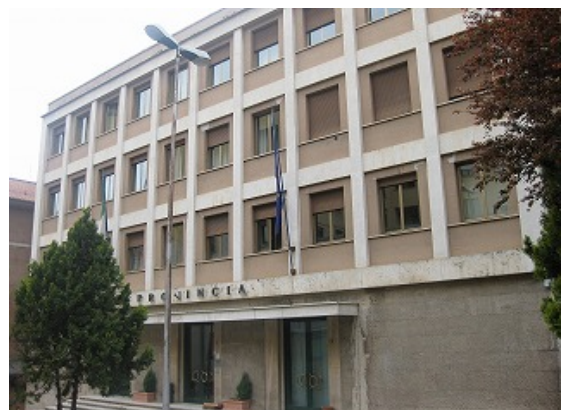
写真-54 行政関係の建物 損傷なし(11)
