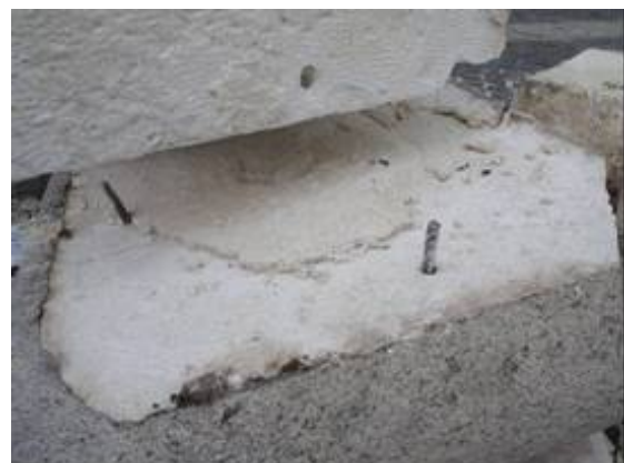
写真-22 ダボ筋による接合
