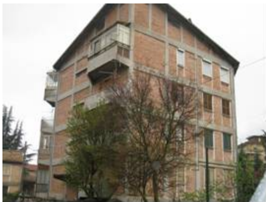
写真-99 4階建てRC造集合住宅
