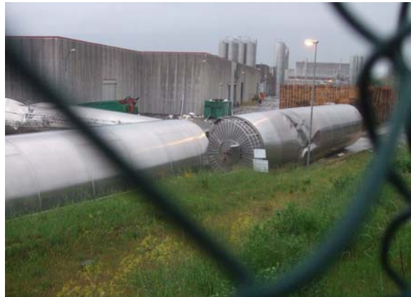
写真-164 バーナーで切断されたサイロ
