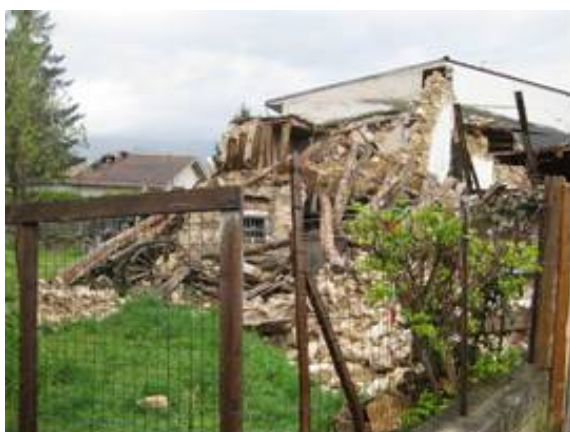
写真-87 組積造の崩壊
