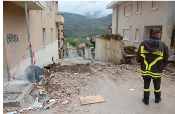
写真-11 応急的に埋め立てられた写真-10 と 同一箇所
