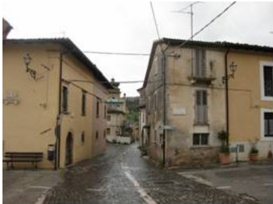
写真-81 封鎖されたオクレの街区
