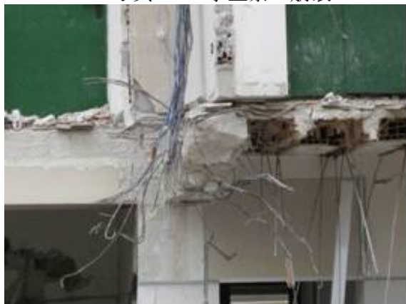
写真-71 2階梁とスラブ
