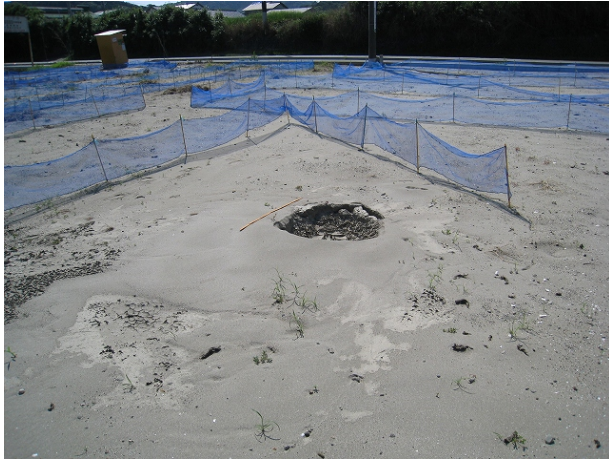
写真1 噴砂跡No.6 (スケールは1m)
