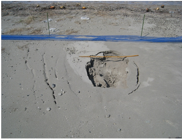
写真3 亀裂を伴う噴砂孔No. 3 (スケールは1m)
