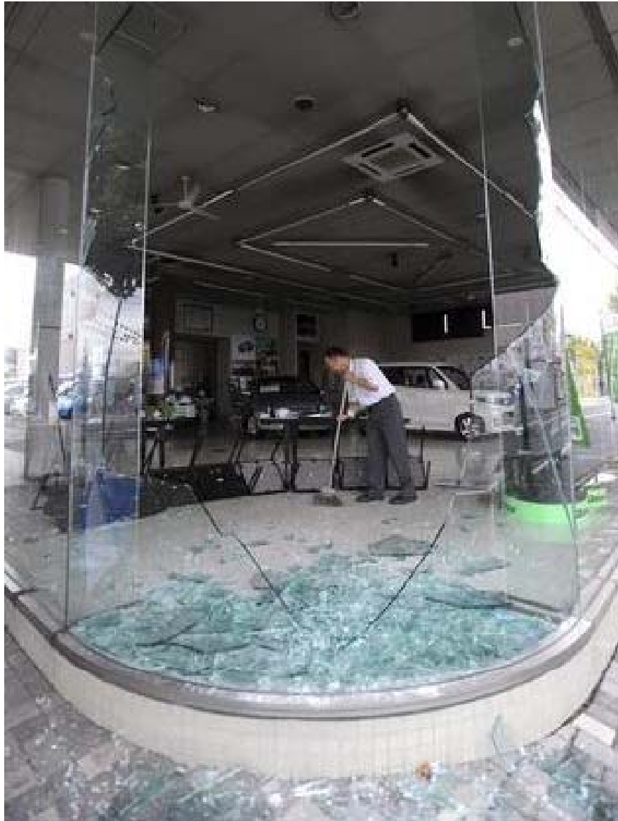
ショーウィンドーのガラスの破壊
