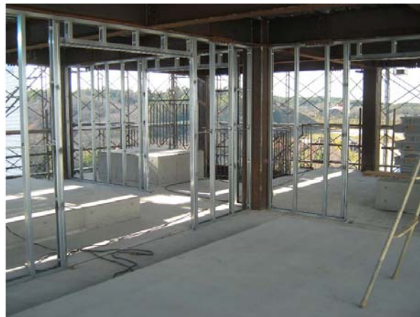
試験体室内の様子(工事中)
