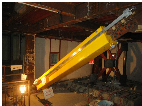
試験体内部の鋼材ダンパー
