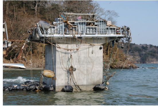
(d) Steel stoppers and seat extenders on P9
