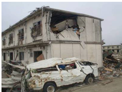
Fig. 29 Debris impact
