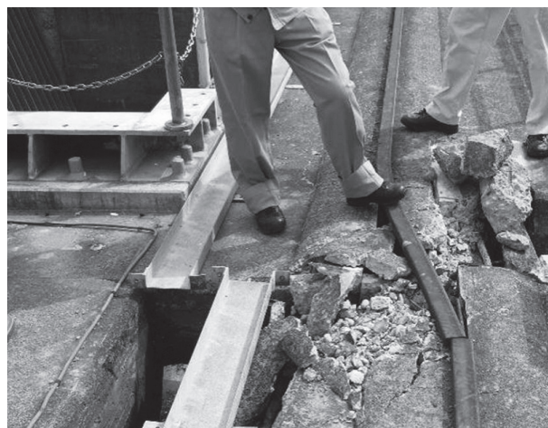
写真11・12 海水の出入り口に設けられたクレーンとその線路の被害
