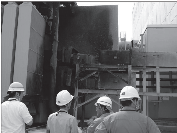
写真6・7 支持台の沈下により、建物と変圧器を結ぶケーブルがショートし発火。変圧器の油に引火して火災となった。
