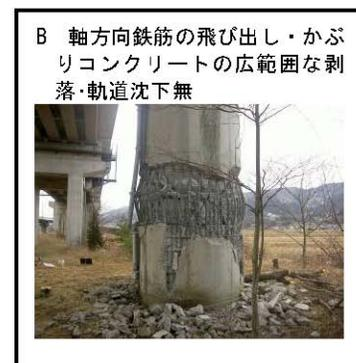
した。幾分沈下したものは、柱を切断して所定の位置にジャッキにてスラブを戻し、鉄筋を接合、帯鉄筋を追加して柱を復旧しました(写真4)。応急復旧を終えて列車は通すこととなりますが、引き続き、鋼板巻きなどの耐震補強をあわせて行いました。
