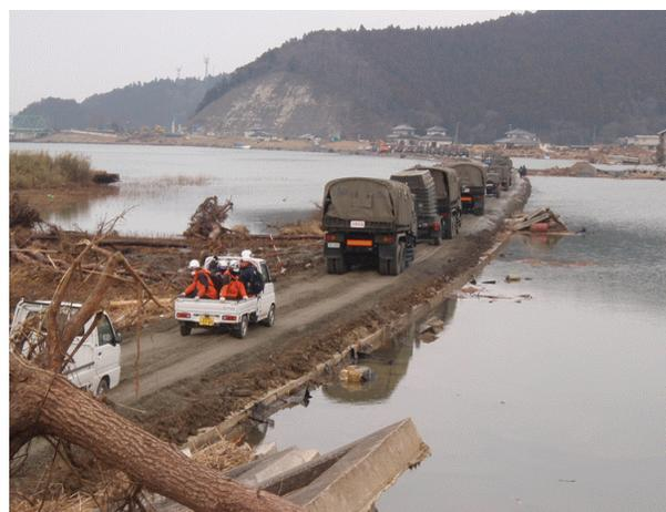
写真8 兼用堤防では道路機能を先行して緊急復旧
