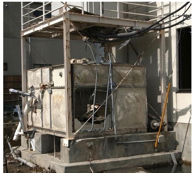
図7 FRP水槽の損傷
