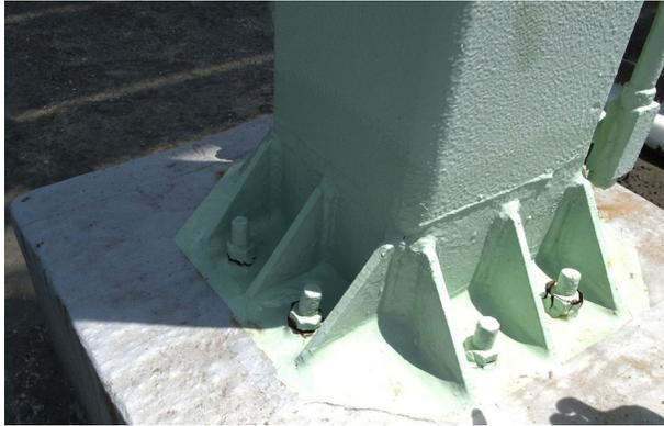
図8 基礎部沈下によるアンカーボルトの伸び
