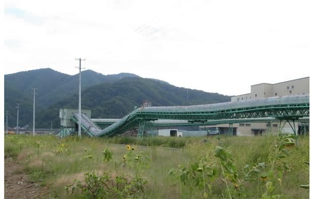
図6 ベルトコンベア支持部の流出
