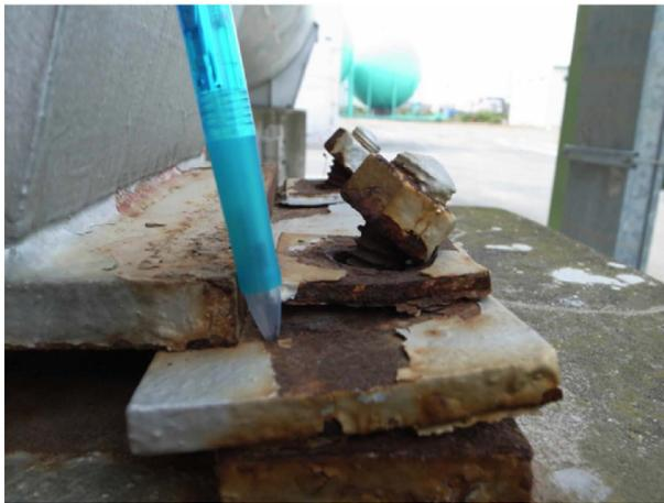
図5 タンクの浮き上がり被害(拡大)
