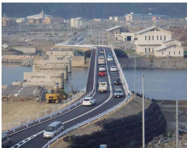
写真7 落橋した気仙大橋が仮橋で復旧した状況
