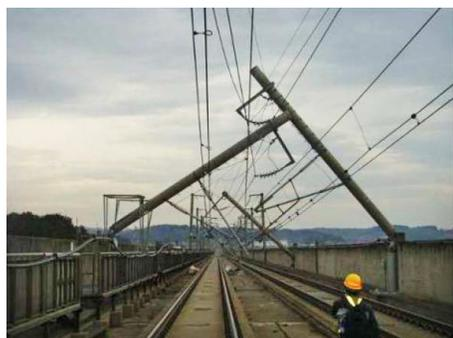
写真5 電柱の被害
