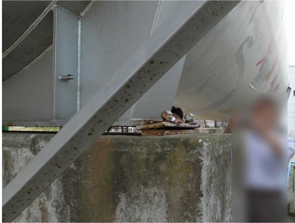
図4 タンクの浮き上がり被害
