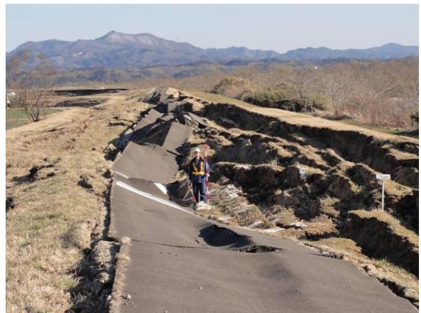
写真1 河川堤防の大規模な被害(阿武隈川下流右岸30.6k+34～31.4k+160)<sup>5)</sup>
