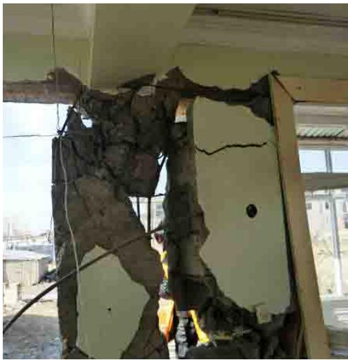
(a) 西側柱のせん断破壊
