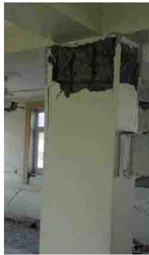
(b) 柱の曲げ破壊
