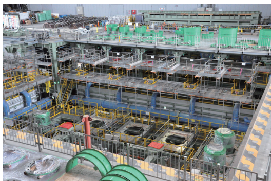
写真1 震動台を外した状況
