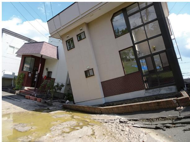
写真4 北海道胆振東部地震による地盤の陥没に伴う住宅の沈下(札幌市清田区里塚)
