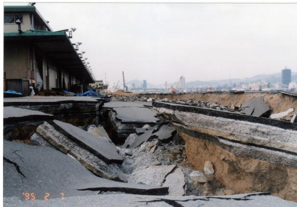
写真2 兵庫県南部地震における護岸移動に伴う背後地盤の沈下と側方流動。左手の倉庫は杭が損傷(神戸市ポートアイランド北部)
