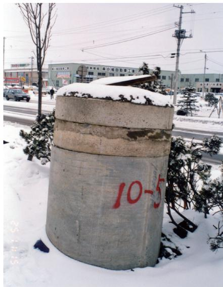
写真1 釧路沖地震で約1.3m浮き上がったマンホール（釧路町）
