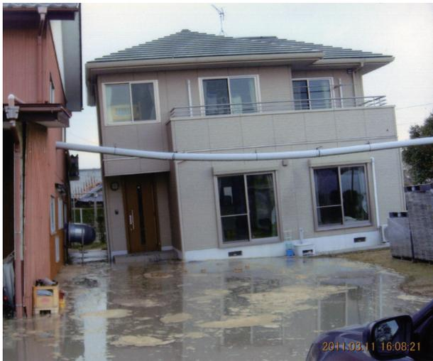
写真3 東北地方太平洋沖地震で液状化によって最大76cm沈下した築4年の住宅(茨城県稲敷市、新里進氏提供)
