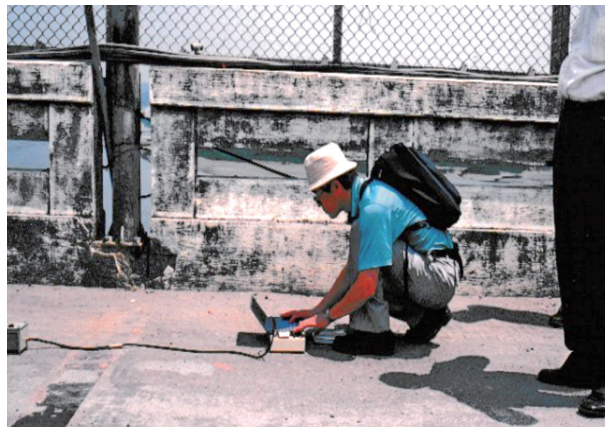
1999年台湾集集地震で被災した石岡ダムでの 常時微動測定（修復工事中、2000年9月20日撮影）
