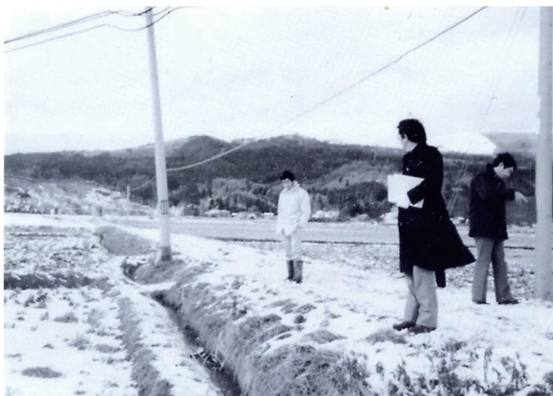
日本海中部地震時のガス導管の被害調査
