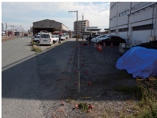
写真1 熊本市西区における表面波探査の様子
