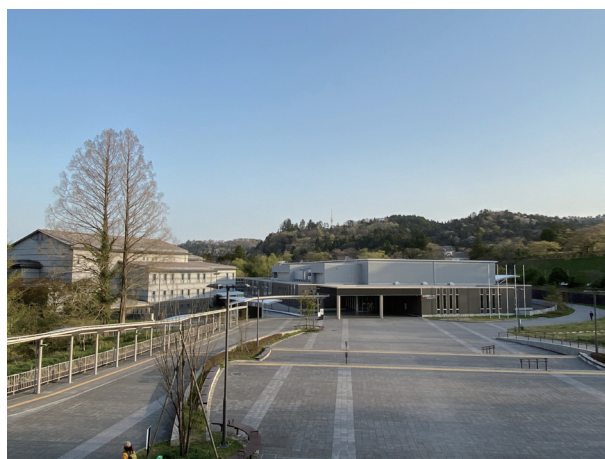
写真3 仙台国際センター（地下鉄駅からの全貌）
