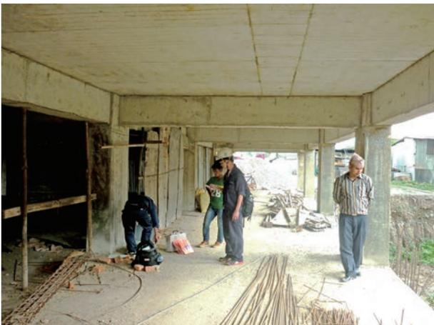
写真2 カトマンズの建物での常時微動計測
