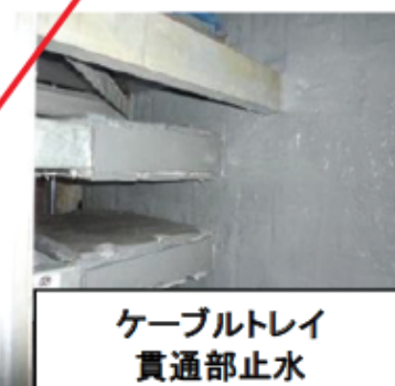
止水処理：重要機器室への浸水防止（約300箇所）
