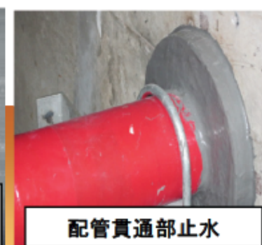
止水処理：重要機器室への浸水防止（約300箇所）
