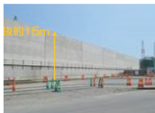
防潮堤：敷地内への浸水を防止
