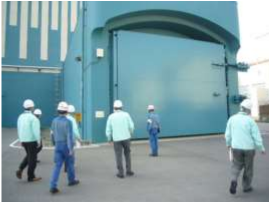
柏崎刈羽原子力発電所（水密扉）
