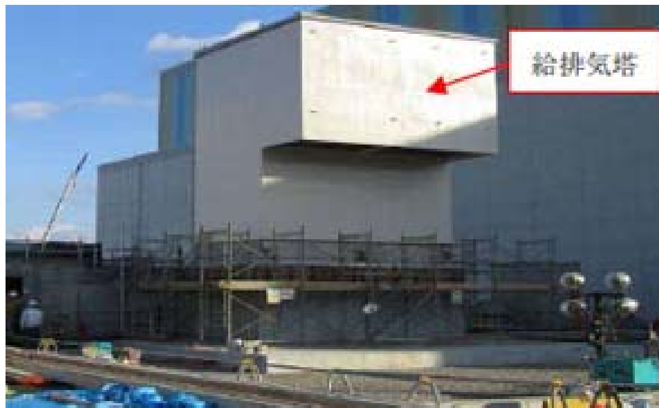
3号機防水蓋・給排気塔の設況置工事の状況 (平成23年11月) 中国電力HPより
