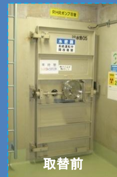
機器室内の水密扉取替状況(3号機の例)
