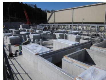
（燃料タンク設置工事の状況）
