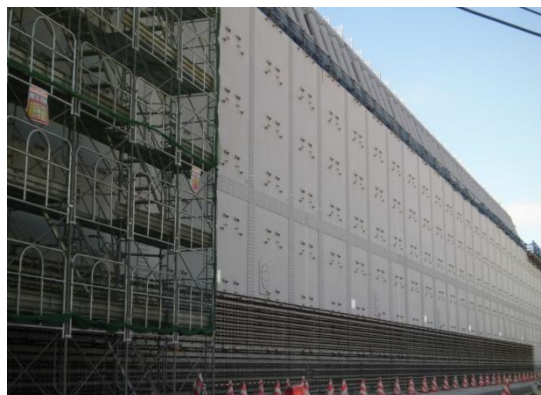
防波壁設置状況 (発電所側より)
