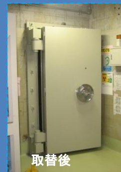
機器室内の水密扉取替状況(3号機の例)
