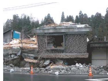
写真 2011年長野県北部の地震で被災した横倉集落での余震観測状況（秦ほか：日本地震工学会論文集、12(2)、pp.60-77、2012.5.）
