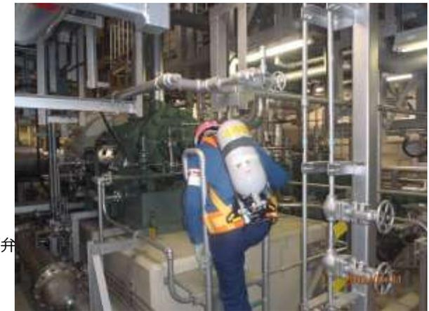
タービン回転数計測（ポンプ側軸受部）
