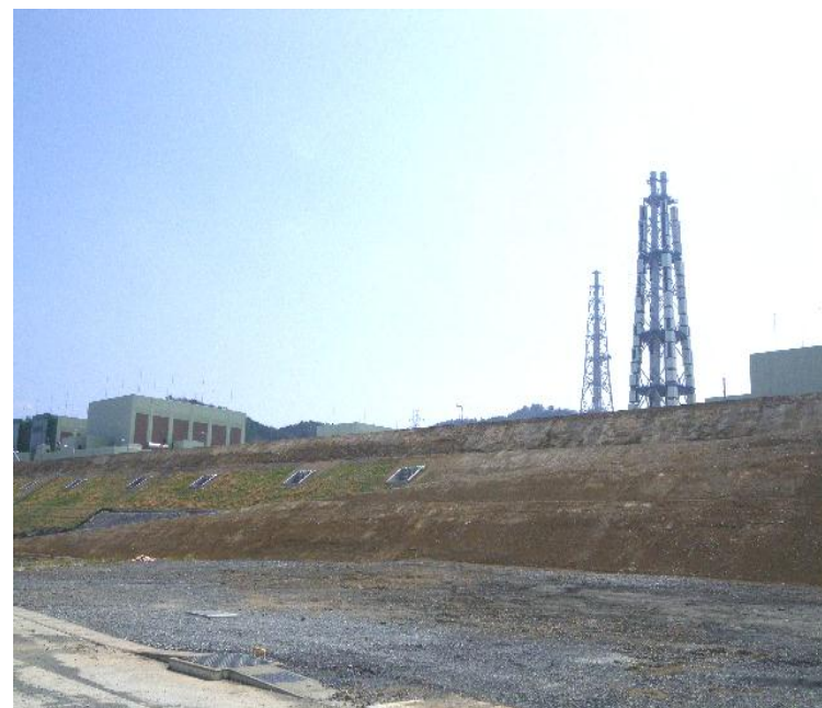
防潮堤設置工事後
