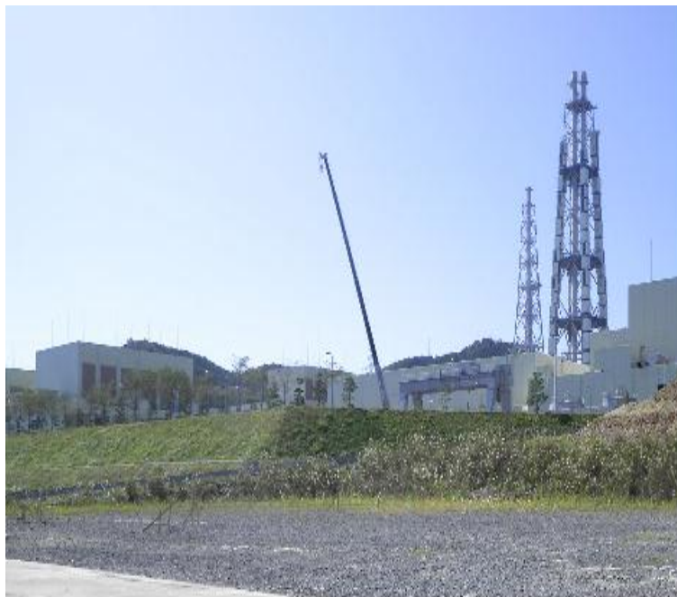
防潮堤設置工事前
