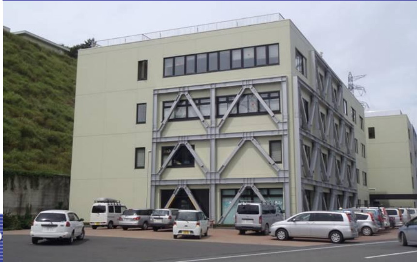
大震災以前に耐震補強工事（筋交い）実施 (平成21年7月～22年3月)
