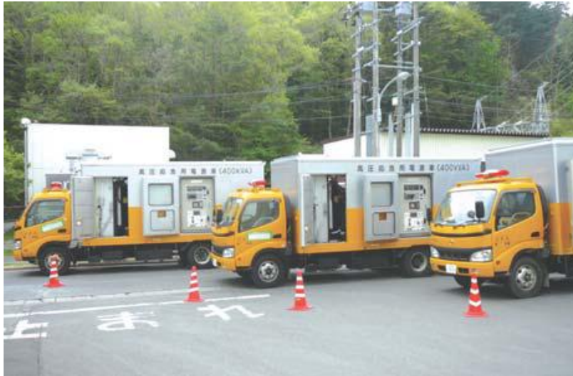
電源車[4台](平成23年3月30日設置)
