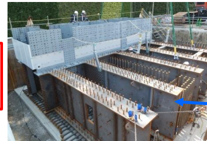
床版組立の様子
