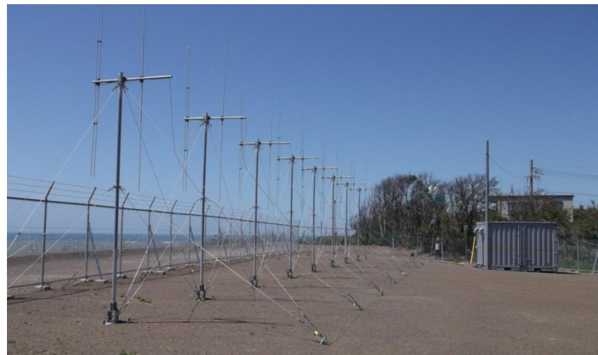
設置したVHFレーダーのアンテナおよび観測所
