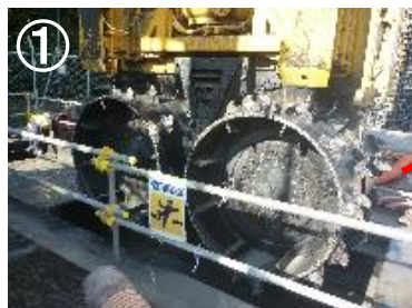
基礎部掘削作業
