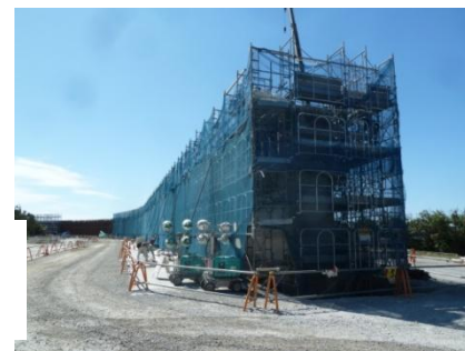
鋼管矢板工事 完了後の鉄筋 コンクリート 打設工事
