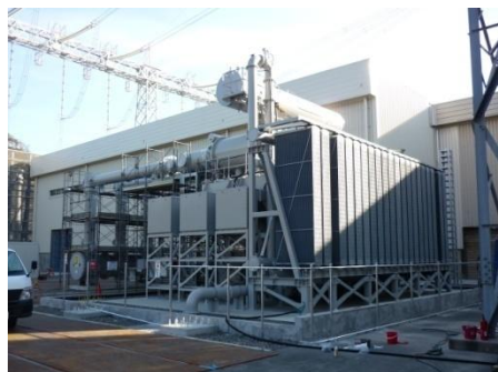
変圧器設置工事
