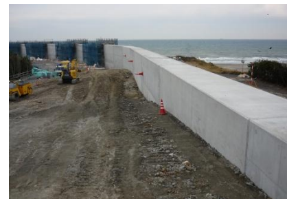
鉄筋コンクリート 打設工事完了 後の状況
