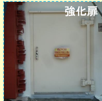
強化扉の設置工事の状況 追設(4号機の例)
