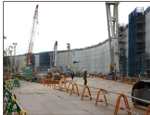
たて壁の設置工事状況
