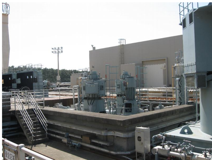
防水壁設置前
