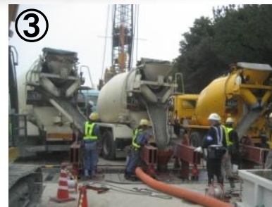
コンクリート打設作業
