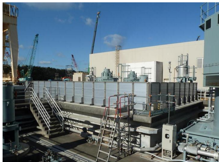
防水壁設置後
