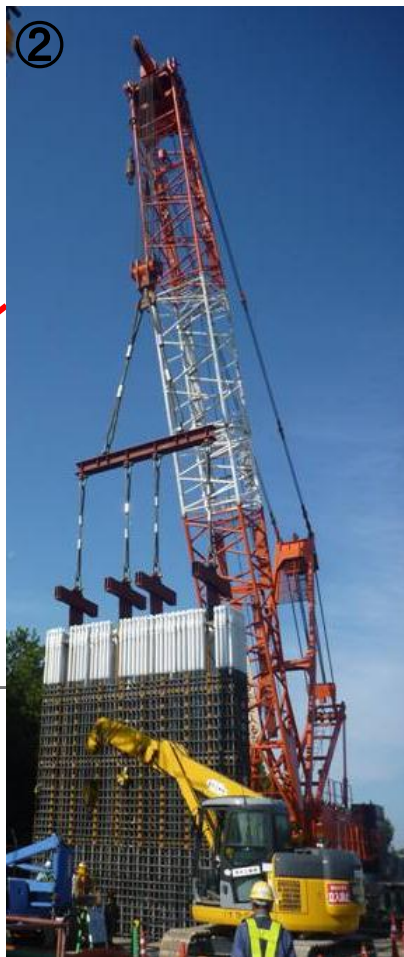
鉄筋建て込み作業
