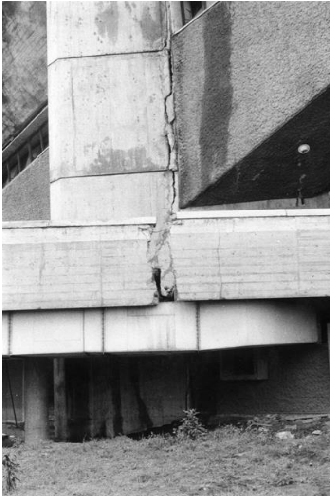
体育館側面入口の渡り廊下が破断している。
