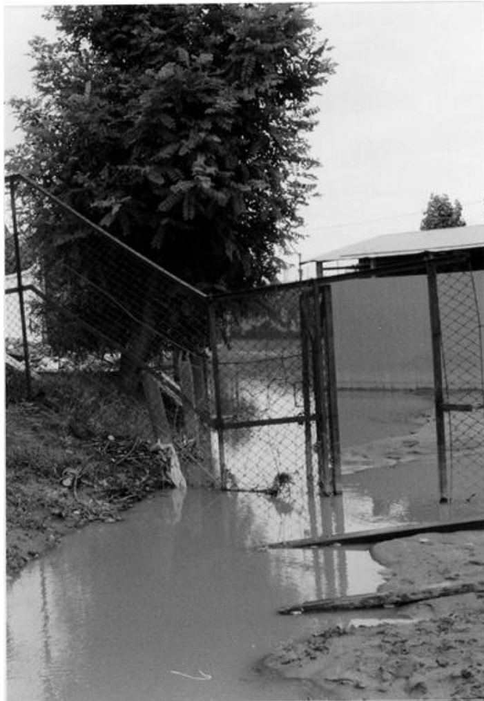
フェンスが沈下して冠水している。
