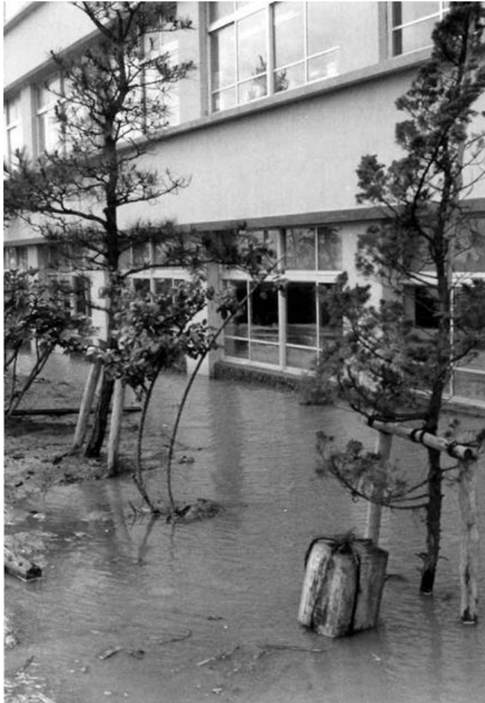
白山高校のRC校舎。校舎が腰窓の下端近くまで沈下している。
