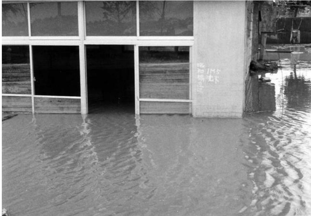
白山高校のRC校舎。浸水しているだけでなく、建物が不同沈下している。柱には、白チョークで1M5（1.5m）沈下と書かれている。
