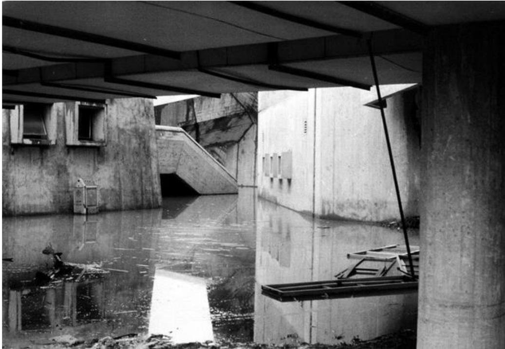
体育館の信濃川寄りの基礎。液状化に伴う側方流動で、地盤が川方向に流出したため、地盤が大きく沈下している。湛水は、液状化で湧出した地下水と、信濃川を遡上した津波で水が浸入したことによるものと思われる。
