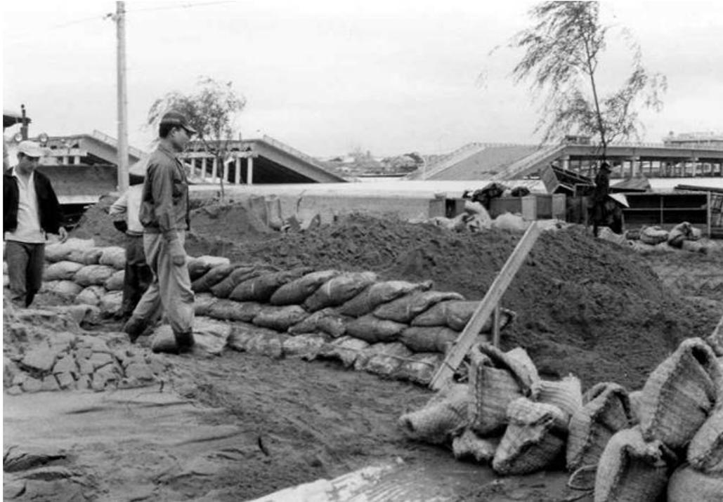
砂と土嚢で信濃川の護岸を応急復旧。
