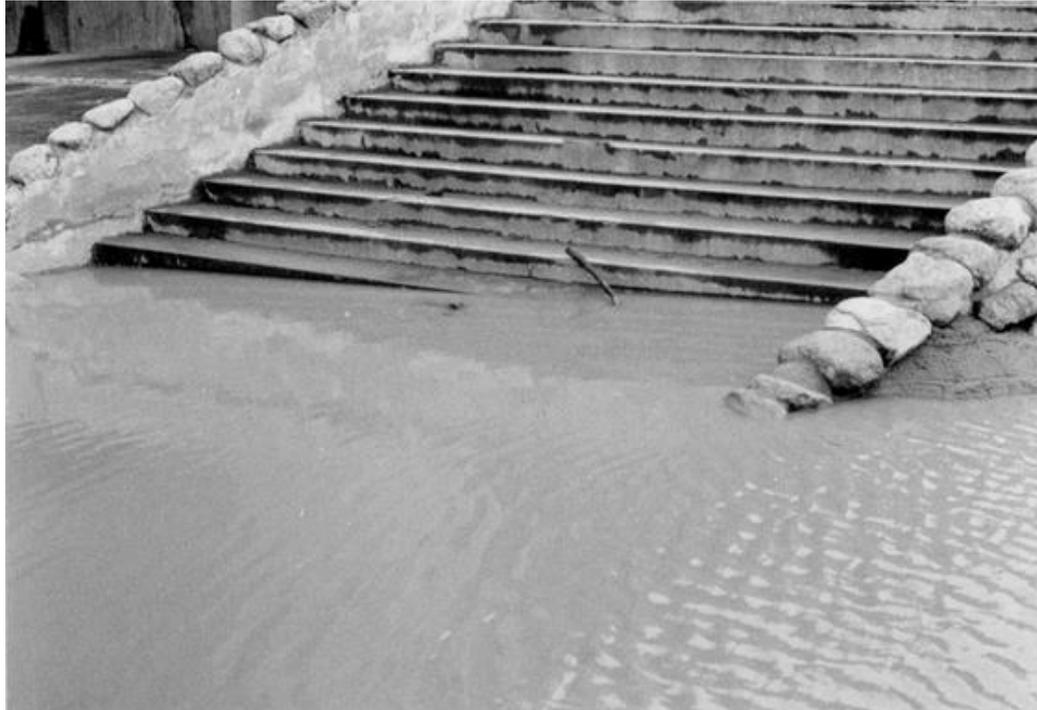
津波と液状化で冠水し噴砂が堆積している。階段の踏面の右側だけ浸水していることから、不同沈下していることがわかる。
