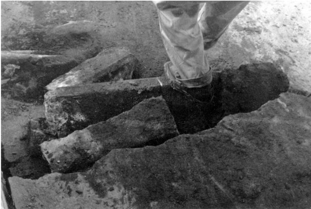
八千代橋の橋桁と東新潟側取り付け道路の境界部付近。詳細は不明だが、圧縮力を受けたような壊れ方をしている。
