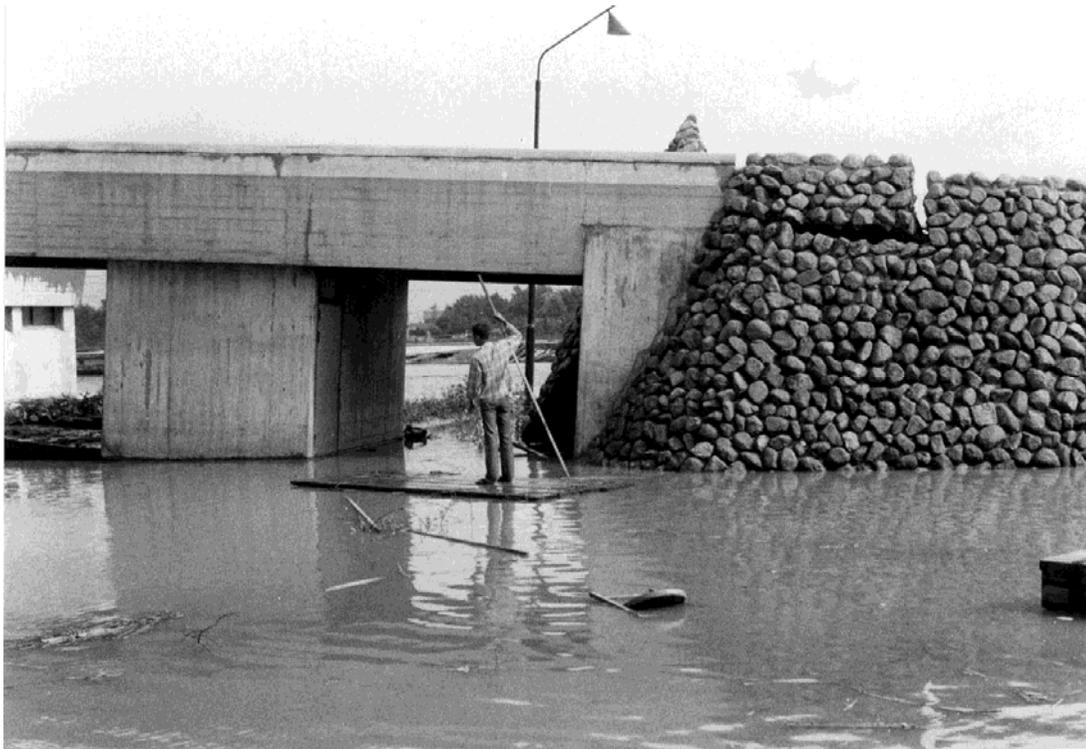
液状化によって冠水している。擁壁が沈下して、大きなクラックが入っている。
