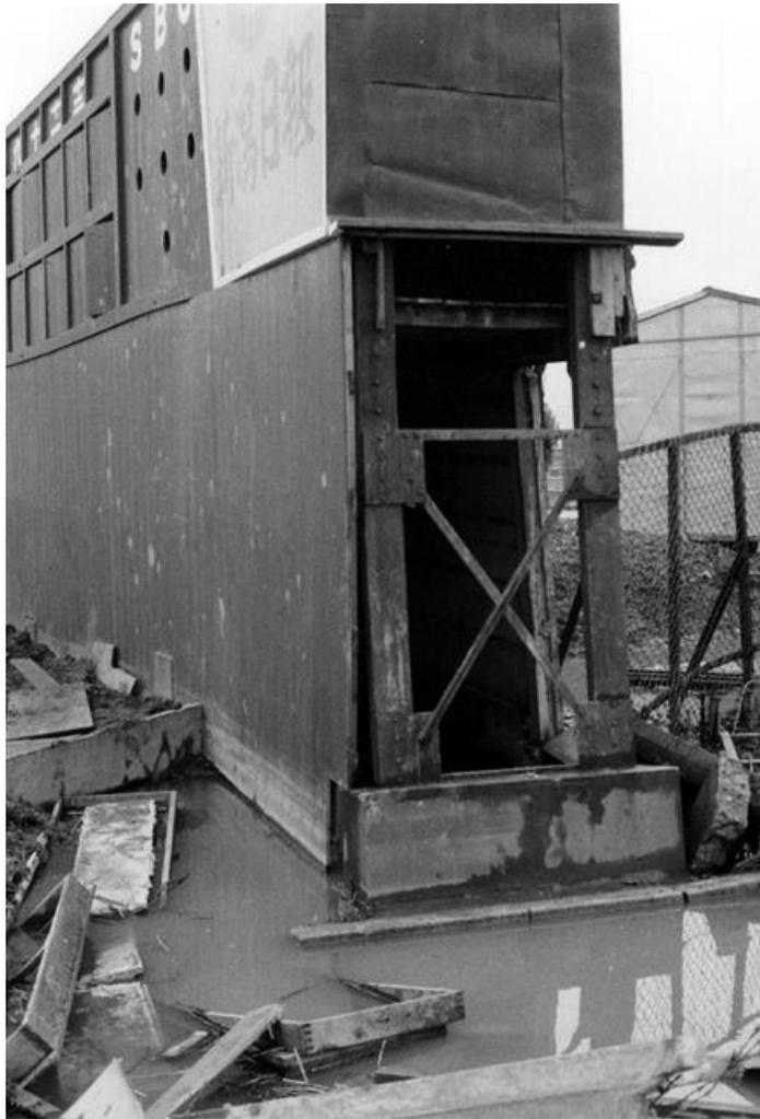
野球場のスコアボード？が傾斜しており、手前は地盤沈下のため、湛水している。津波による漂流物と思われる木片等が散乱している。
