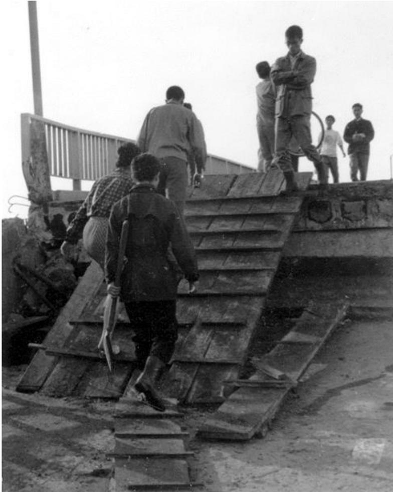
西新潟側の取り付け盛土が沈下して橋台との間に段差を生じたため、板を渡して通行している。滑り止めの横木がついた板を誰が急遽設置したのだろうか。
