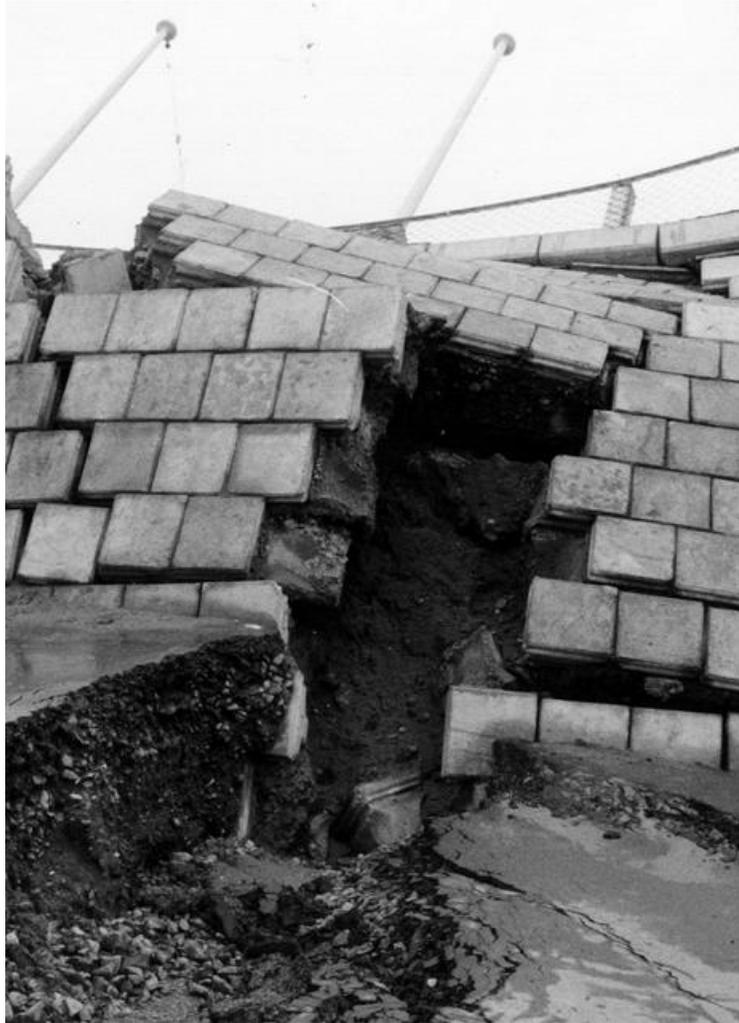
大きな地割れが横切り競技場の擁壁が崩壊している。
