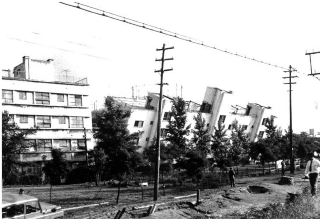
アパートが沈下して傾いている。傾いた方向は前や後ろとまちまちだ。このアパートは4階建てだが、杭は打たれておらず直接基礎だった。手前には噴砂も見える。
