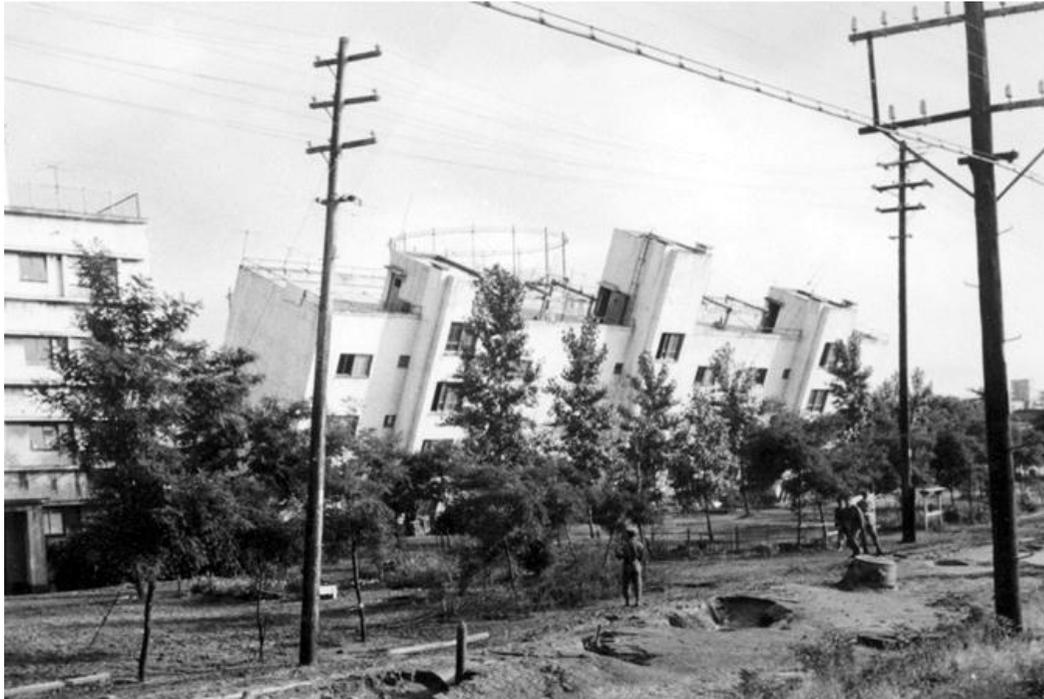
前と同じ写真のクローズアップ。手前に噴砂やマンホールの浮き上がりが見える。頑丈そうなアパートが傾いたのに、電柱がほぼ真っ直ぐ立っているのが不思議。
