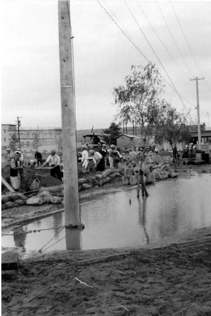
地盤沈下によって信濃川の水が浸入するのを防ぐため土嚢を積む。
