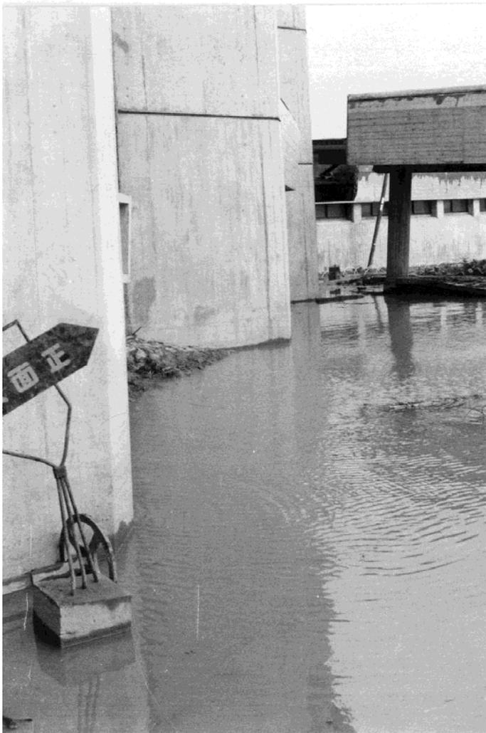
津波と液状化の両方で一面冠水している。
