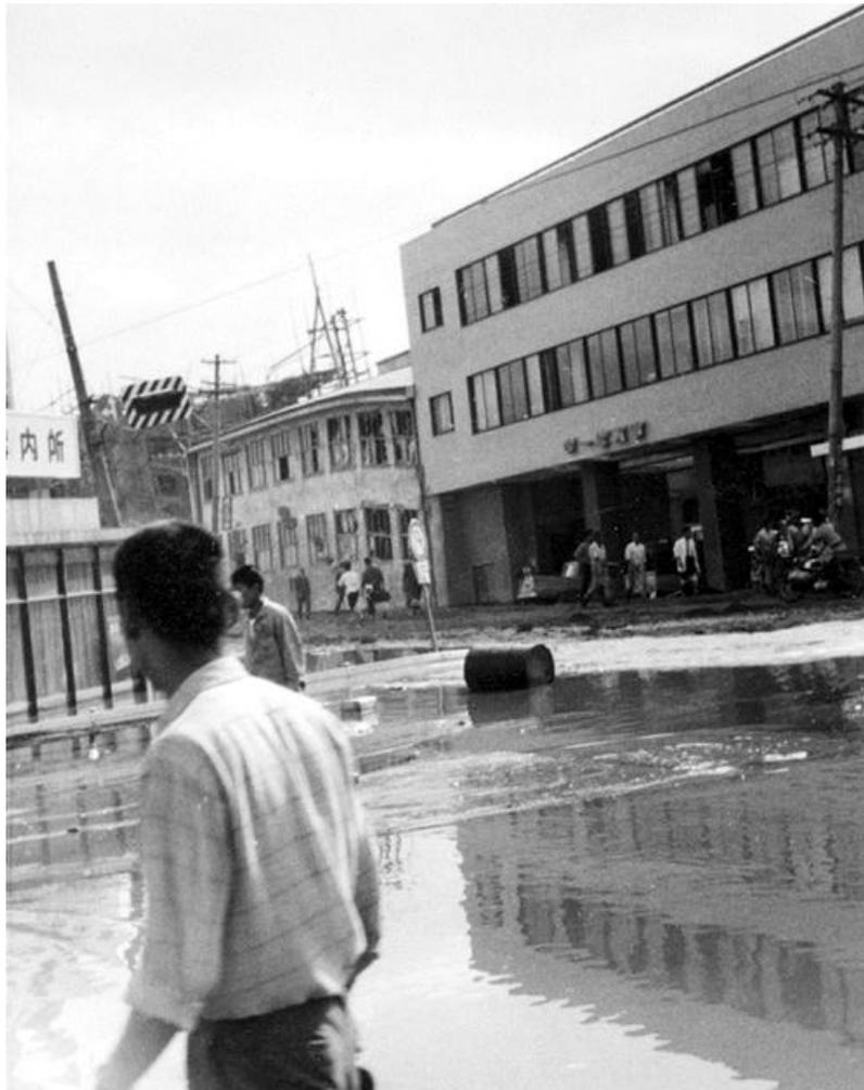
津波と液状化で道路が冠水している。建物も信号機も全て傾斜し、傾斜の基準が見つからない。奥の建物の沈み込みも著しい。地盤災害図によれば周辺は一面噴砂。
