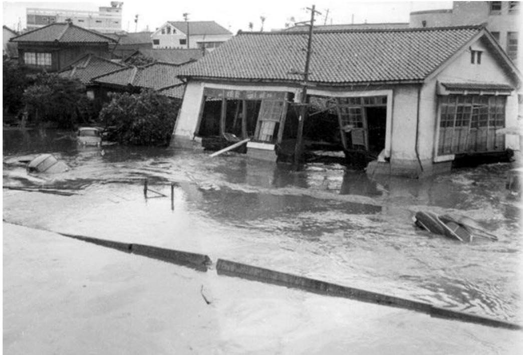
側方流動により護岸(手前)が沈下して割れ目が入り、津波が浸入した。液状化で沈下した建物も浸水し、車2台が土中深く斜め沈み込みこんでいる。液状化した地盤にはまり込んだところに津波で浸水したと思われる。家屋や電柱の根元が川側(手前)に引っ張られるような形で傾斜している。液状化と津波の複合災害の典型である。
