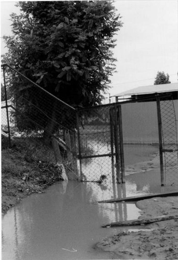
フェンスが沈下して冠水している。
