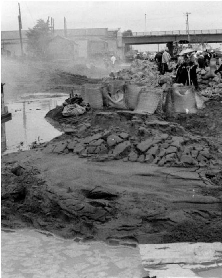
信濃川の護岸応急復旧の様子。右手が信濃川、左手の護岸道路はまだ水が引かない。
