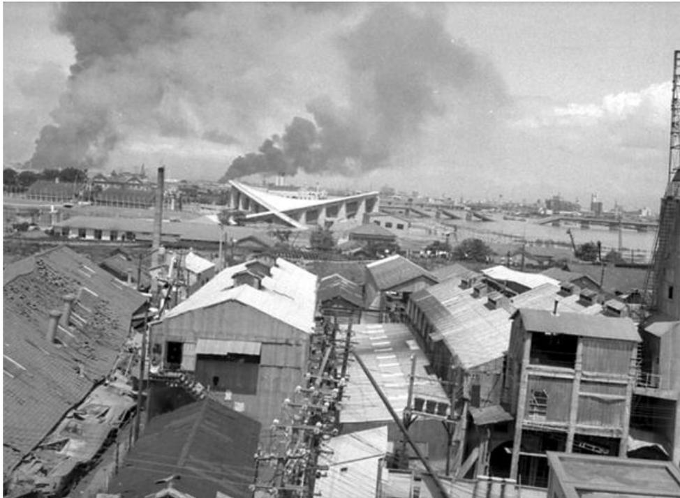
No.30とほぼ同じ写真。遠方に沈下した県立競技場と落橋した昭和大橋が見える。煙は2箇所から上がっている。写真の右手前の建物は傾いている。
