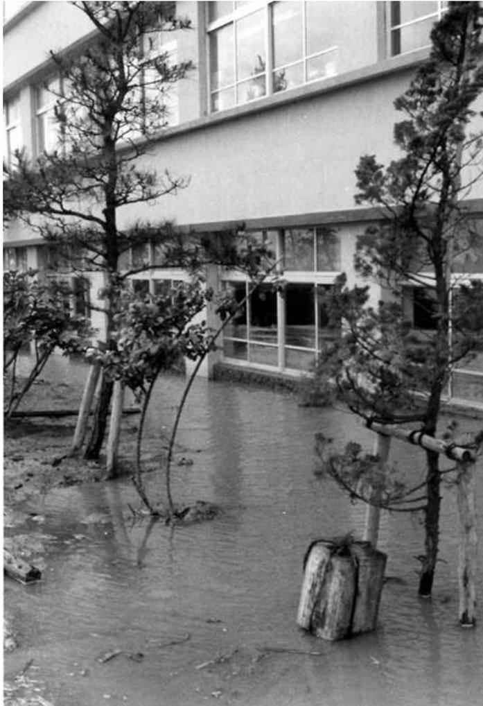
白山高校のRC校舎。校舎が腰窓の下端近くまで沈下している。
