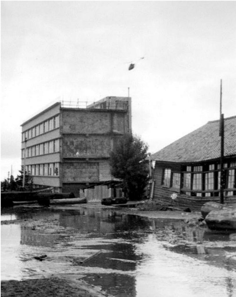
噴砂や津波の浸入により冠水した川岸。右手の木造校舎は沈下して大きく歪んでいる。
