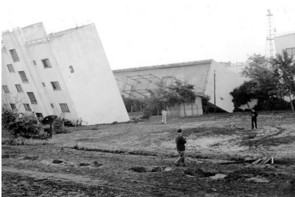
液状化して大きく傾斜した川岸町アパート3号棟。奥の4号棟は転倒して屋上が見えている。敷地には、噴砂が広がり、噴砂孔には水が溜まっている。
