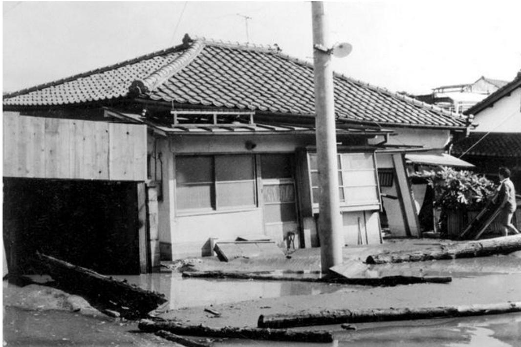
液状化と津波により道路は冠水。家屋が沈下し後ろ側に傾いて沈み込んでいく。
