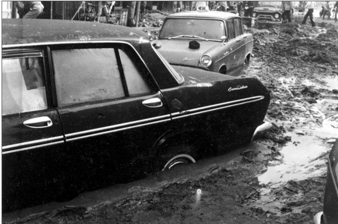
地震2日後の18日に撮影。液状化した土砂に車が埋って動けなくなっている。6月16日午後撮影したNo.47と同じ場所。2日経過して水は引いたが、状況は変わらない。
