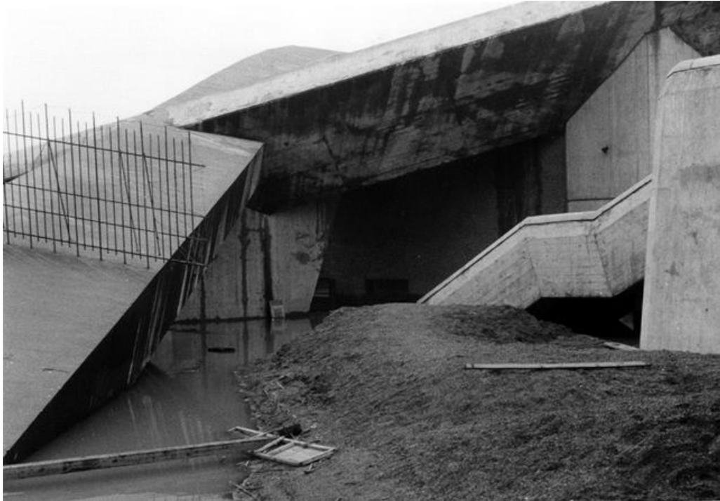
写真手前右側は、左側は側方流動によって地盤沈下したため、水が引かない。
