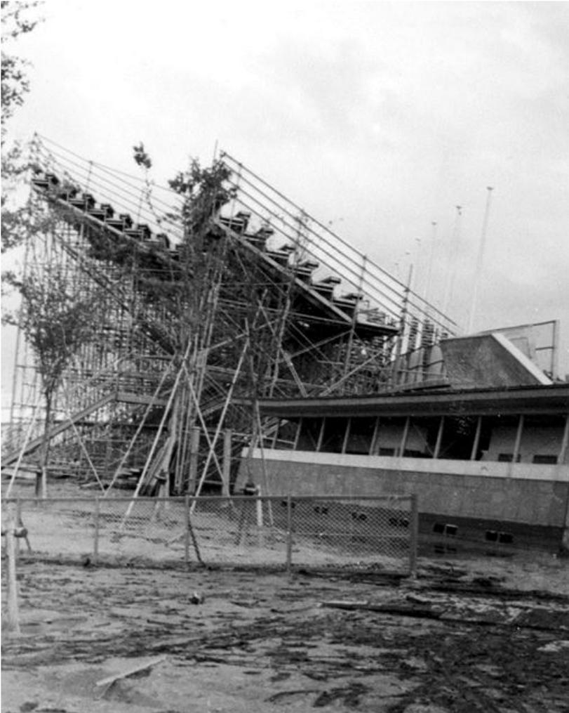
仮設スタンド、建物やフェンスが沈下して大きく傾いている。
