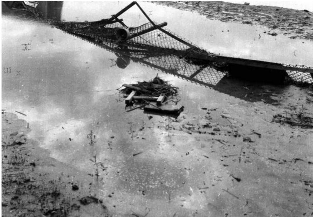
No.128の写真と同じフェンス。液状化した地盤に津波が浸入し、泥濁化している。
