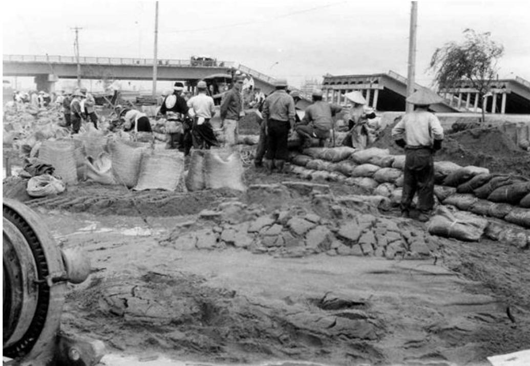
信濃川の護岸応急復旧の様子。落橋したままの巨大な昭和大桥の姿が無残である。
