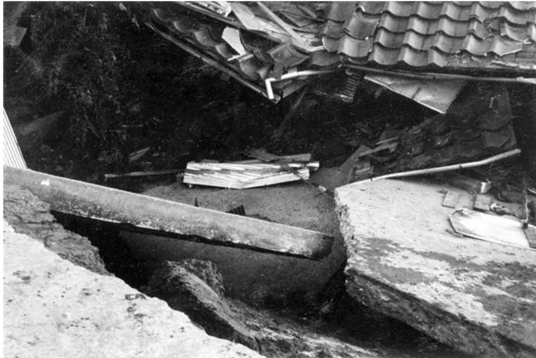
道路が崩落し、家屋は全壊。振動による倒壊のようにも見えるが、地盤変状も関与している？
