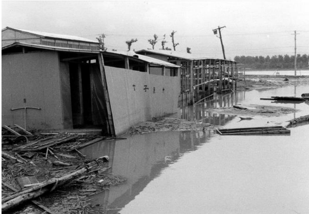
野球場の南側から信濃川方向を撮影した。地盤が沈下して写真奥の信濃川の水位とほとんど変わらない。水中から顔を出している地面は噴砂の山、左手前に散乱しているのは、津波が運んだ漂流物と思われる。
