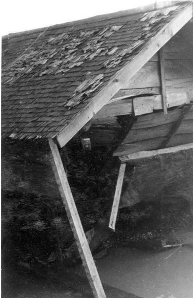
建物が歪んで倒壊している。浸水しているのは液状化によって噴き出した地下水によると思われる。
