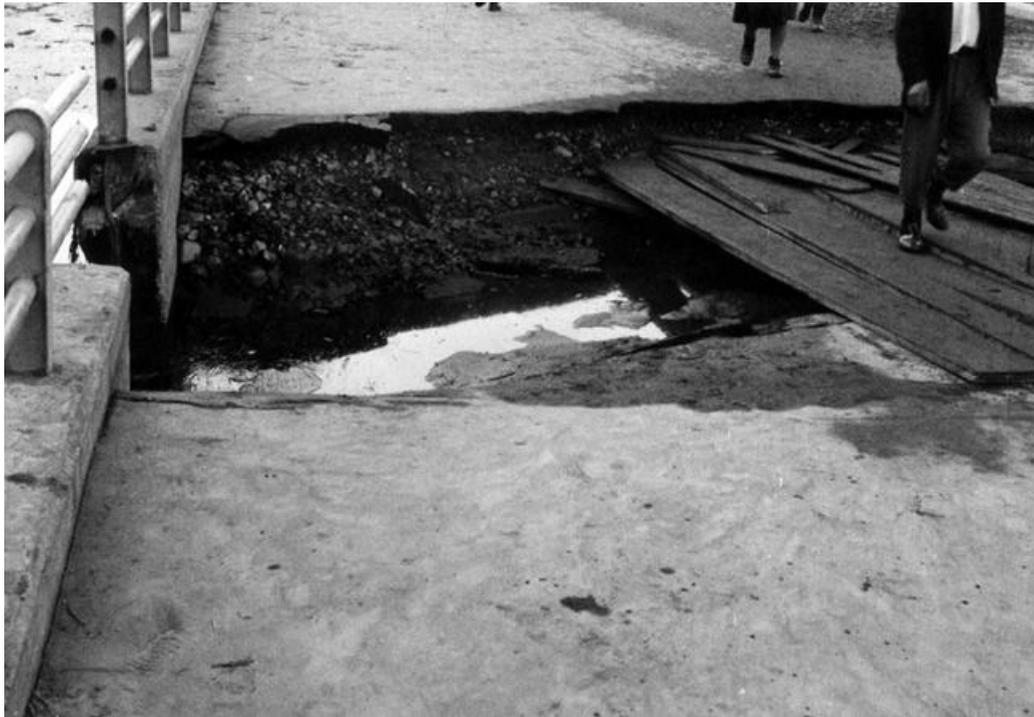
橋台と東新潟側取り付け道路に段差と離れを生じている。
