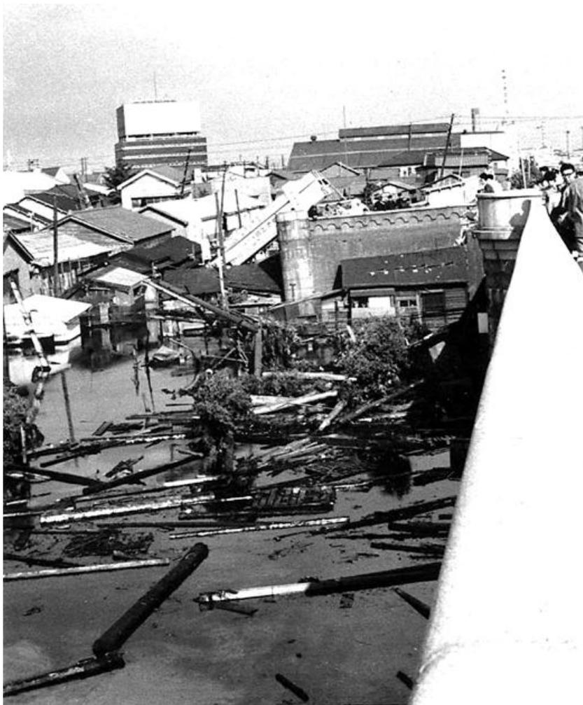
護岸が液状化で崩壊して、津波が浸入した。津波漂流物が散乱している。中央の建物が傾いているのは液状化の影響と思われる。
