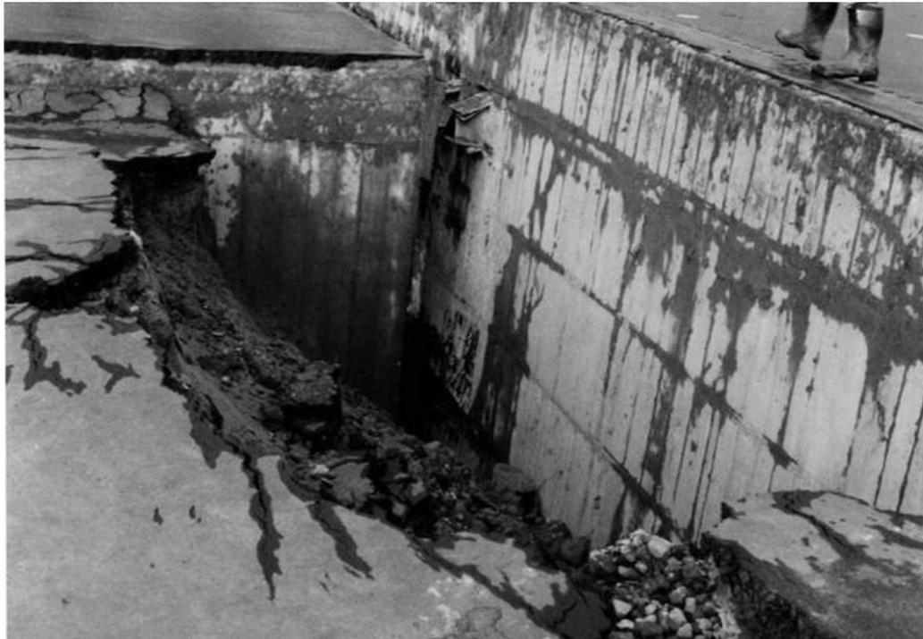
昭和大橋取り付け道路が沈下し、橋台との間に段差を生じている。
