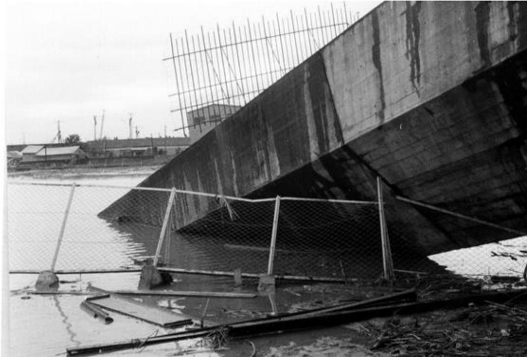
不同沈下した体育館の梁でフェンスが押しつぶされた。津波と液状化によって冠水している。
