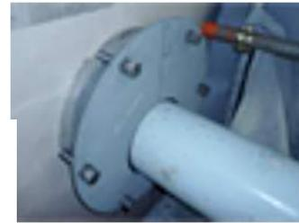
図 7.4-3 配管貫通部止水シールの例<sup>7.4-5)</sup>
