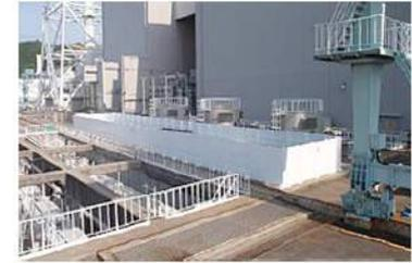
写真 7.4-4 取水口周辺の防水壁の例<sup>7.4-6)</sup>
