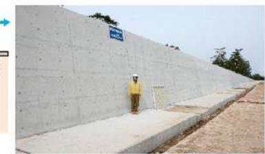
図 7.4-4 防潮堤の排水ゲートの例<sup>7.4-7)</sup>
