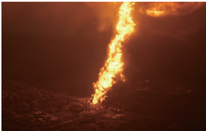
写真 2011年3月11日に千葉県内の製油所で発生したLPGタンクの爆発・火災（千葉市消防局提供）
