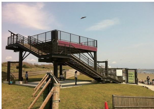
写真3 海岸沿いの津波避難タワー
